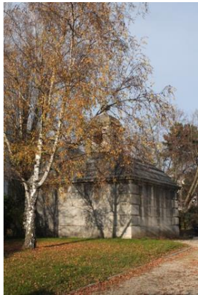
Regard 1 – Aqueduc Médicis (Cerema)
