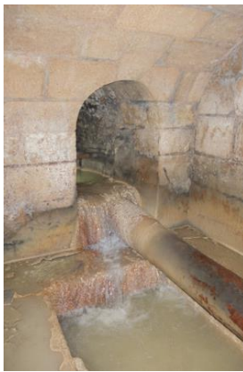
Regard 10 – Aqueduc Médicis (Cerema)
