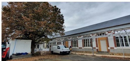
Résidence Gassiot à Pau Accessibilité avec Ascenseur extérieur et Façade arrière « galerie béarnaise »
