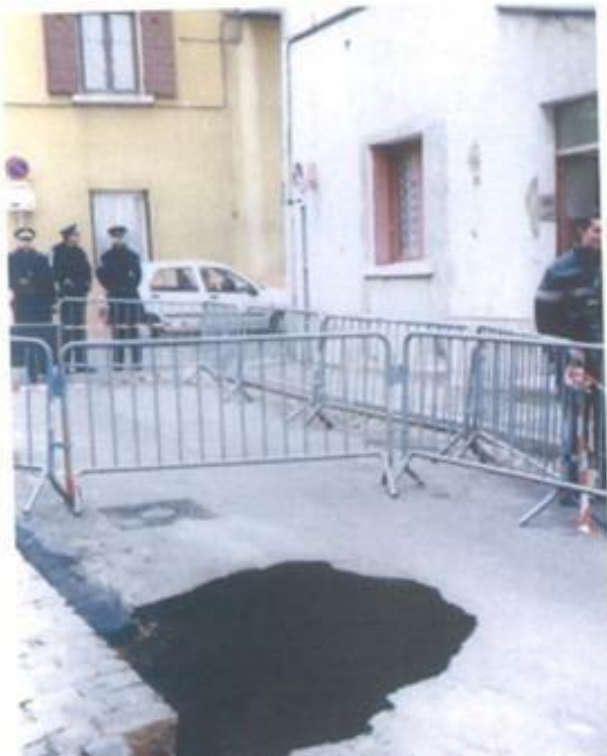
Fontis rue des Pépinières Lyon 5 e (1996) – 2m de diamètre - 4/5m profondeur – apparu
