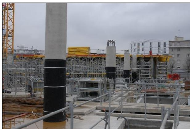
Figure n°24 : Début de la construction de la dalle vague qui va recouvrir la PFES – vue des poteaux support (23/12/2011).
