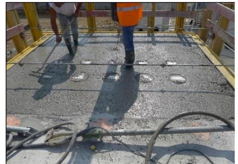
Figure n°37 : Fin du coulage du second plot d'essai.
