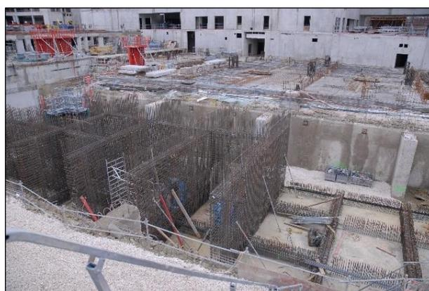
Figure n°20 : Installation du ferrailage des premiers raidisseurs.
