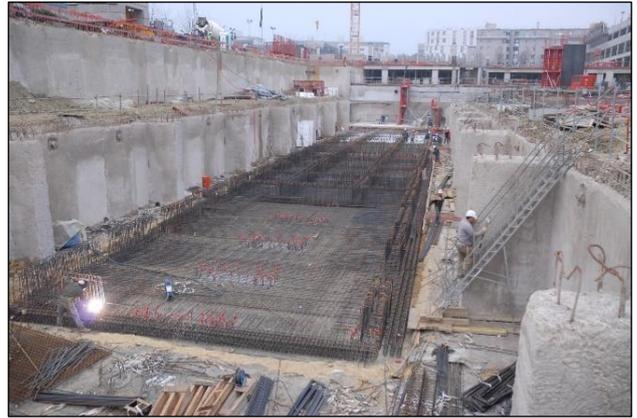
Figure n°12 : Vue générale du ferrailage du radier en cours de montage.
