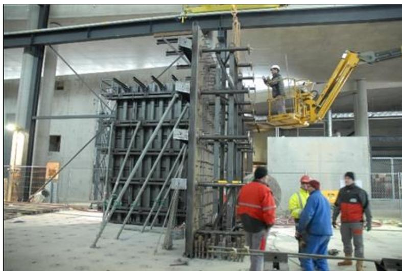
Figure n°59 : réglage fin des puits horizontaux.
