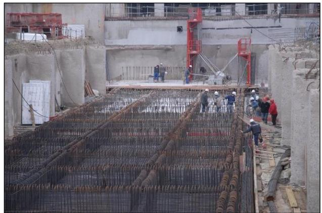
Figure n°14 : Amorces de ferrailage des voiles des raidisseurs.
