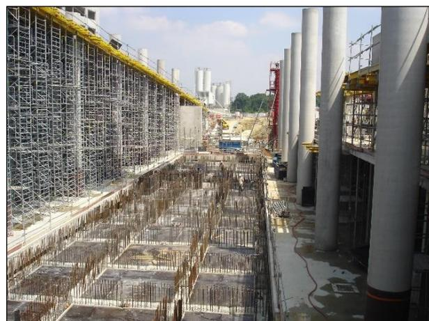
Figure n°26 : Les raidisseurs sont bétonnés, les poteaux support de la toiture sont fabriqués.
