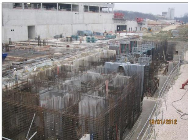
Figure n°25 : avancement de la construction des raidisseurs.
