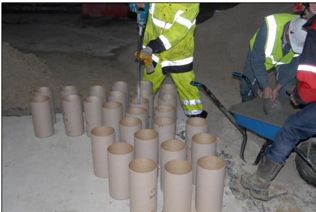
Figure n°49 : Fabrication des éprouvettes de contrôle du plot 2.
