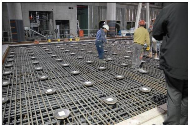
Figure n°43 : Ferrailage du plot 2.
