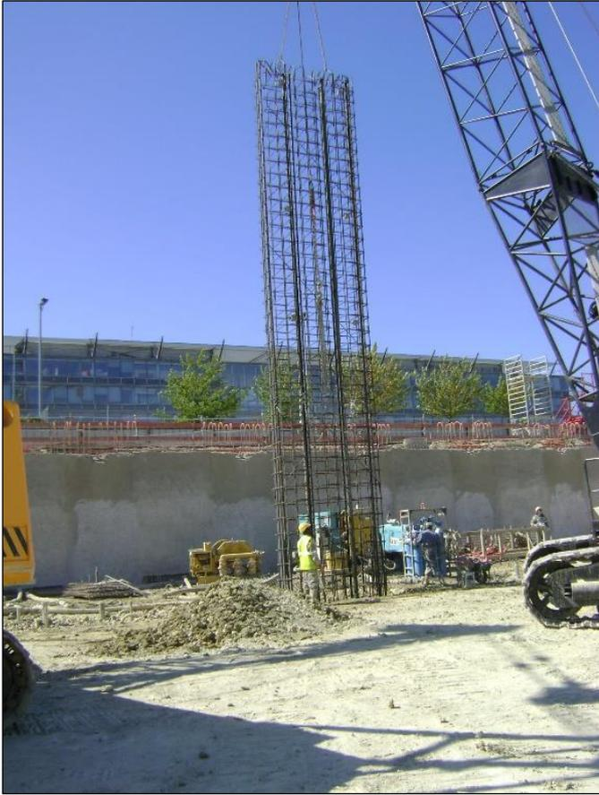
Figure n°13 : Cage de ferrailage d'une barrette en cours de pose.
