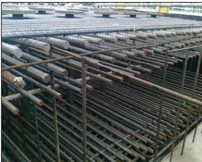
Figure n°35 : Ferrailage en cours d'installation dans le second plot d'essai.
