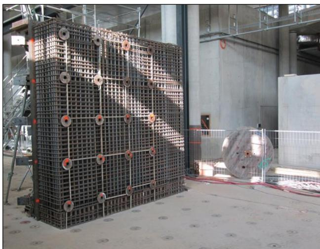
Figure n°60 : Ferrailage des murs
