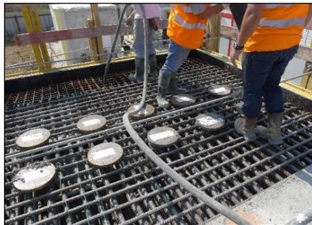
Figure n°36 : Bétonnage en cours du second plot d'essai.
