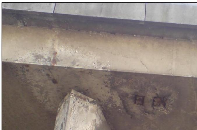
Figure 1 : Visualisation de fissures et de rouille sur armatures sur l'intrados d'une dalle de ponts (Cerema)
