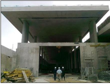
Figure n°32 : Couverture de la PFES par la dalle vague.
