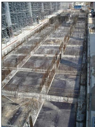
Figure n°28 : Vue générale de l'installation du coffrage de la dalle supérieure du caisson.
