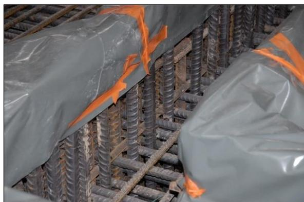
Figure n°45 : Densité très importante des armatures à l'encastrement des murs sur la dalle.
