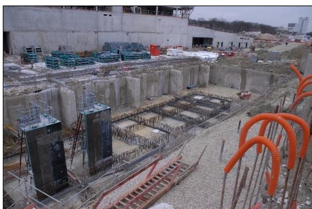
Figure n°21 : Installation des premières banches pour le coulage des raidisseurs.
