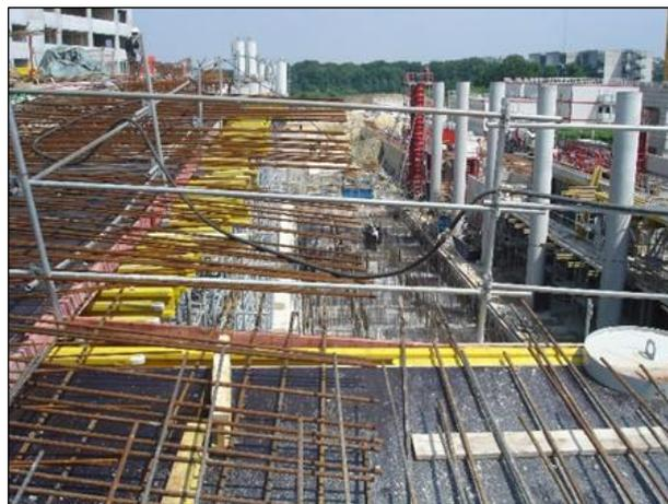
Figure n°31 : Dalle vague Ouest en cours de ferrailage et arrivée de la dalle vague Est au niveau de la PFES.
