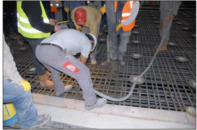
Figure n°48 : bétonnage et vibration du plot 2.
