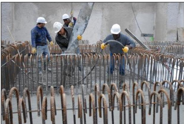
Figure n°15 : Coulage du béton et vibration en cours du béton du radier.
