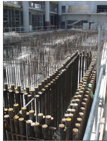
Figure n°29 : Armatures en attente avec coupleurs du mur de réaction longitudinal.
