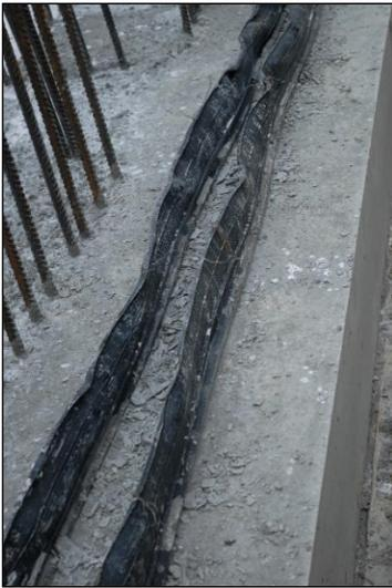
Figure n°17 : Joint d'étanchéité placé sur le pourtour du radier
