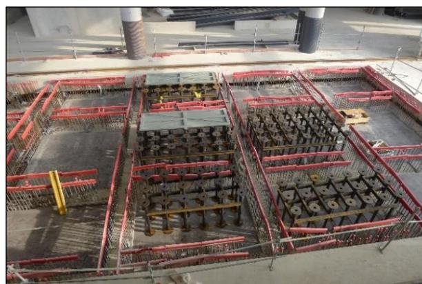
Figure n°42 : Installation des puits d'ancrage dans le plot 4.
