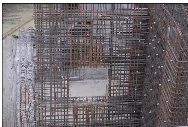
Figure n°22 : Détail du ferrailage d'un raidisseur autour d'un trou d'homme.
