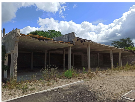
Site de la future résidence sociale
