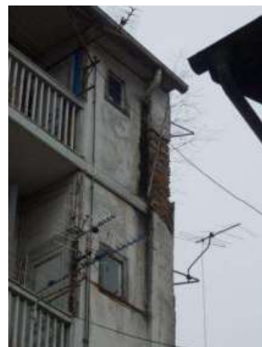
Façade côté cour Source Habitelem-Domofrance
