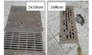
Plaques avaloir d'assainissement de voirie non conformes et sur un cheminement
