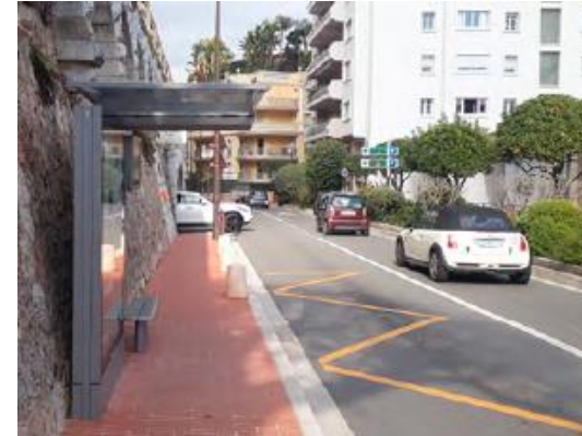
Cas d'un arrêt sur trottoir très contraint, avec abris casquette (manque ici guidage et marquage au sol vers portes bus)
