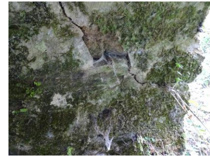
Fracture vue sur le tympan et en intrados
