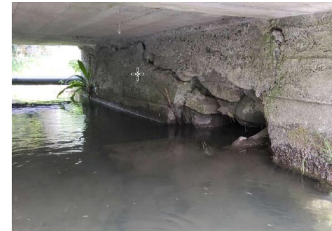
Rupture de la dalle centrale
