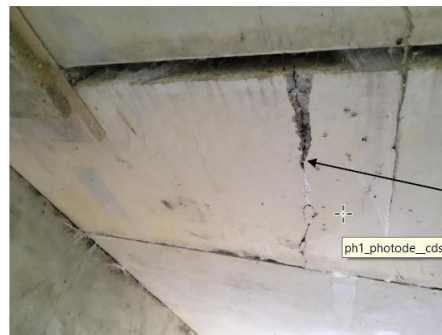
Rupture de la dalle centrale
