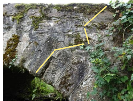
Fracture vue sur le tympan et en intrados
