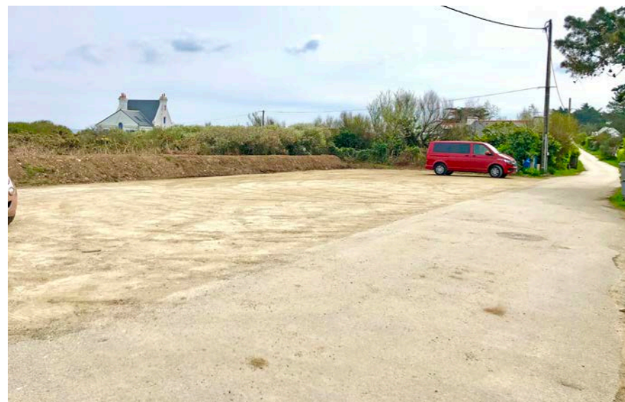
Stabilisation d'une zone de stationnement
