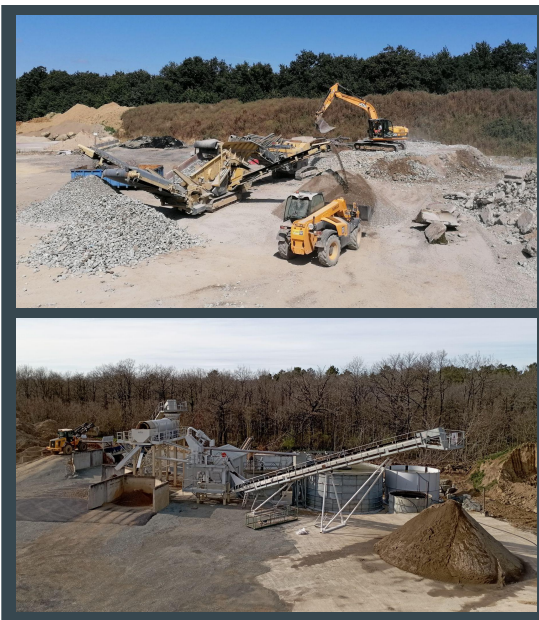
Valorisation des matériaux
