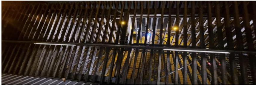
**Capteur installé à l'intérieur des GC et fixés à l'aide d'une chaînette et sangle à cliquet - Passerelle Claude Bernard**
