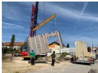
Mur de la chaufferie en béton de chanvre (hors site)
