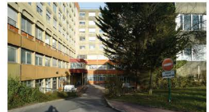
bâtiment 5 - chirurgie 1+ (photo du haut) / bâtiments 6 - chirurgie 2+ (trois photos du bas)
