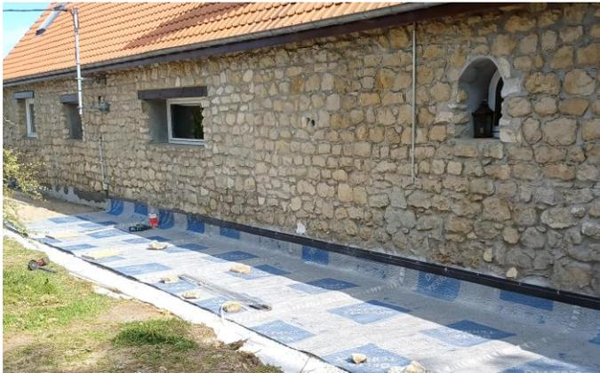
Géomembrane avec un drain de surface
