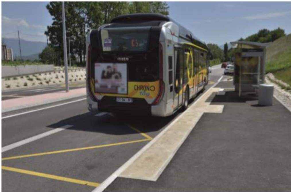
Zone de sécurité contrastée visuellement et tactilement
