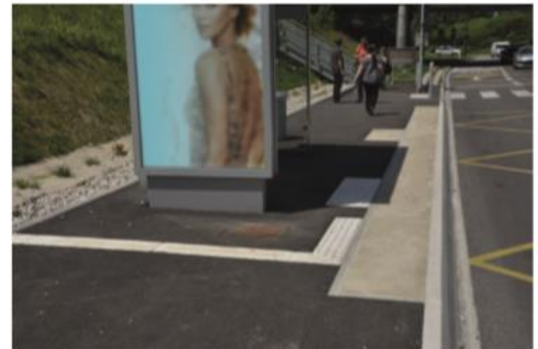
Bande d'interception placée perpendiculairement au cheminement et s'arrêtant au niveau de la bande de sécurité
