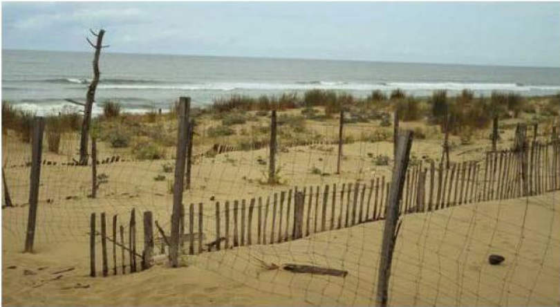
Fig.6. Exemple d'utilisation de méthodes «douces» pour la stabilisation des plages (Charente-Maritime - ONF)
