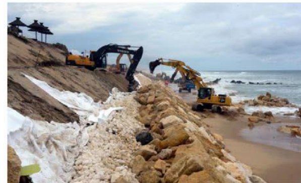
Fig.7. Remblaiements et reconstruction de digues sur le littoral de Lacanau-Océan, suite à la tempête du 20 mai 2014. (source : AFP)
