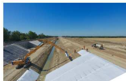
Digue Tarascon-Arles - pose du géotextile
