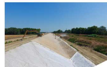
Pose de graviers
