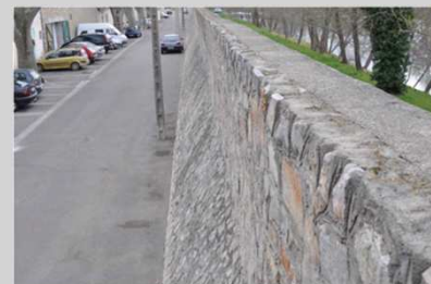
Digue poids en maçonnerie à Comps (30) Source : R. Tourment
