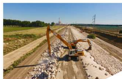
Digue Tarascon-Arles - pose d'enrochements
