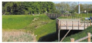
Bassin d'infiltration à l'échelle d'un espace vert
