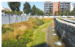
Bassin d'infiltration à l'échelle d'un quartier
