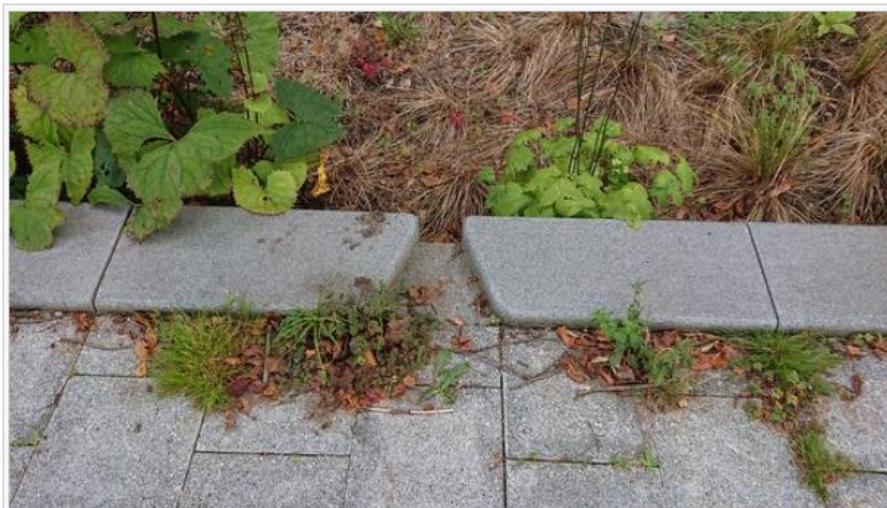
Figure 1 : Mettre les voiries à une cote supérieure à celle des pelouses et prévoir des passages pour l'eau est une façon extrêmement efficace et peu onéreuse de déconnecter des surfaces imperméables ; crédit photo : Jean Pierre Tabuchi.
