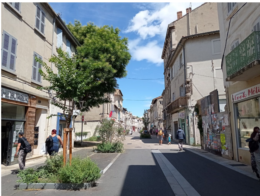
BANDE STRUCTURANTE INTÉGRANT LA GESTION DES EAUX DE RUISSELLEMENT AU PROFIT DES PLANTATIONS RÉAMÉNAGEMENT DE L'AXE HISTORIQUE CARNOT-CARRETERIE À AVIGNON | SAFRAN, 2022
