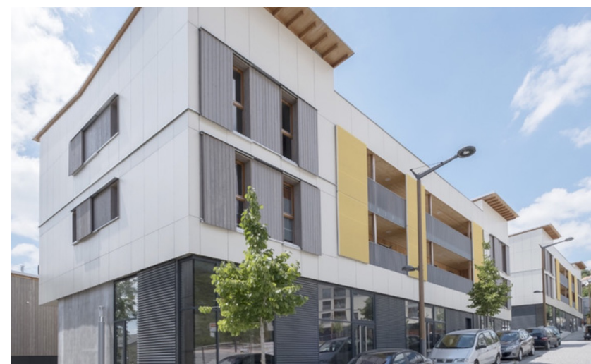
Logements en structure mixte bois-béton (référence : écoquartier Trémonteix, 63)
