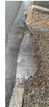
> Eau de ruissellement s'infiltrant dans la tranchée d'un arbre de pluie
