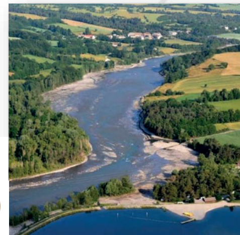
Restauration hydromorphologique élargissement et recharge sédimentaire du lit du Drac, CLEDA (05)
