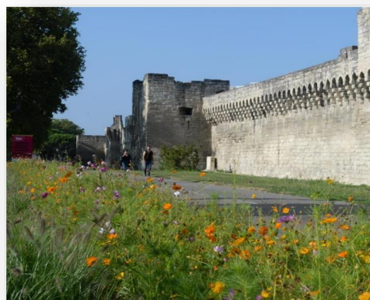
Désimperméabilisation et végétalisation Avignon (84)
