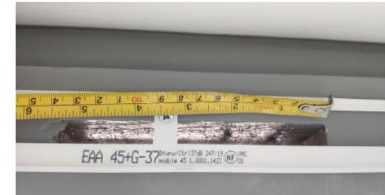
Détail de la notice Anjos-ventilation pour le dimensionnement des entailles des entrées d'air
