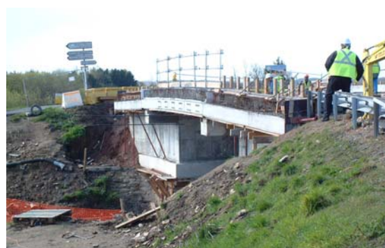
Mise au gabarit d'un ouvrage d'art
