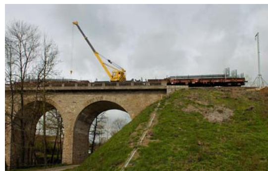
Pose de poteaux caténaires successifs
