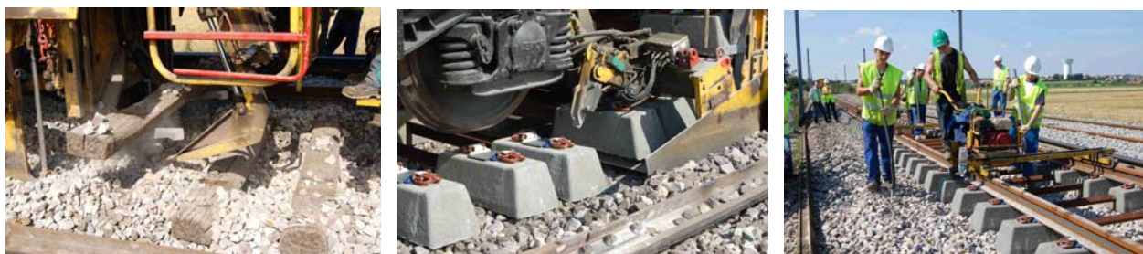
Figure 6 - Illustration de la substitution des traverses et de la fixation des LRS (Source : CETE Nord-Picardie)
