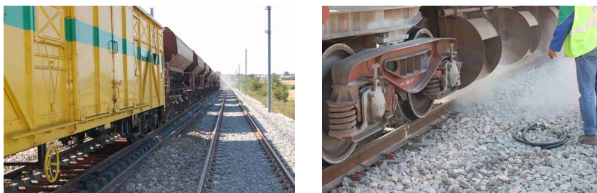
Figure 7 - Illustration du déchargement du ballast (Source : CETE Nord-Picardie)
