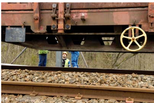
Etais supportant un poteau caténaire
