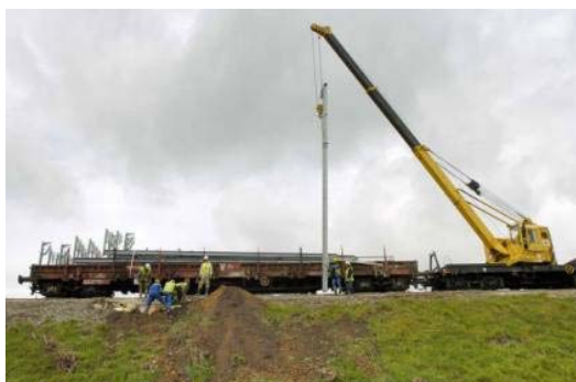
Pose d'un poteau caténaire
