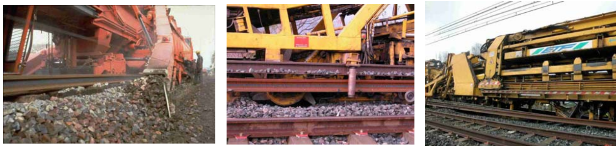
Figure 5 - Illustration du dégarnissage de la voie (Source : CETE Nord-Picardie)
