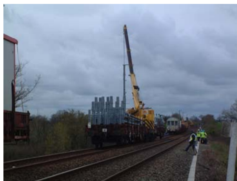
Train de fouille, train de matage et avant du train de béton
