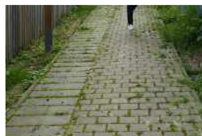
Pavés enherbés, groupe scolaire Stéphane Hessel-les Zéfirottes, Montreuil © CAUE de Paris
