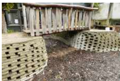
Ponton entre deux buttes maçonnées à l'école Toverbol, Anvers © CAUE de Paris
