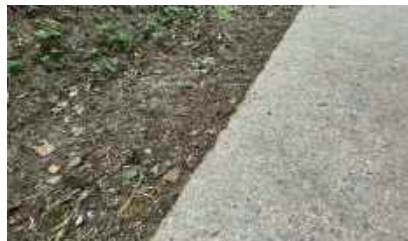
Béton désactivé, Paris © CAUE de Paris
