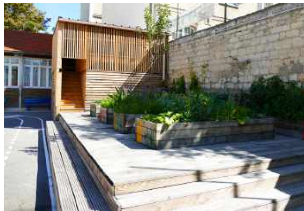
Terrasse de jardinage avec une profondeur de terre de 1,20m, école 14 Riblette, Paris © CAUE de Paris
