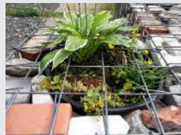
Gabion rempli de matériaux divers
