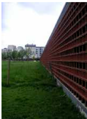
Mur de clôture, facilement réversible et qui laisse passer la petite faune, parc Eole, Paris © CAUE de Paris
