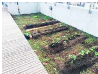
Toiture terrasse plantée, école Saint-Merri, Paris © CAUE de Paris
