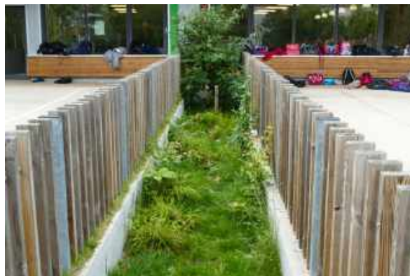
Fossé planté, école primaire Stéphane Hessel, Montreuil © CAUE de Paris
