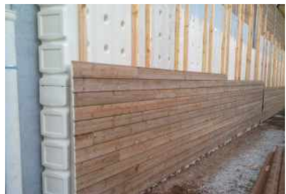
Exemple de stockage modulaire aérien, recouvert d'un bardage bois © Murdeau
