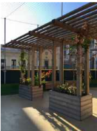
Pergola en bois avec poteaux ancrés dans les jardinières, école Dovella, Barcelone © CAUE de Paris
