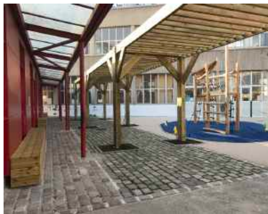
Pergola en bois avec ancrage au sol dans des fosses de pleine terre, école Emile Levasor, Paris © CAUE de Paris
