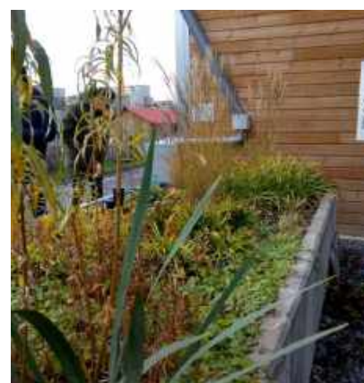
Jardin de Pluie à Saint-Denis hors sol, avec récupération de l'eau de pluie d'une toiture © Ville de Paris
