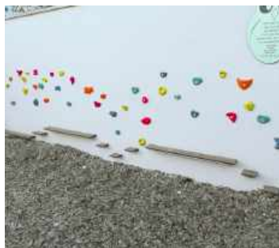
Réalisation d'un mur et support de jeu, en remplacement d'une grille provisoire, école Thionville, Paris
