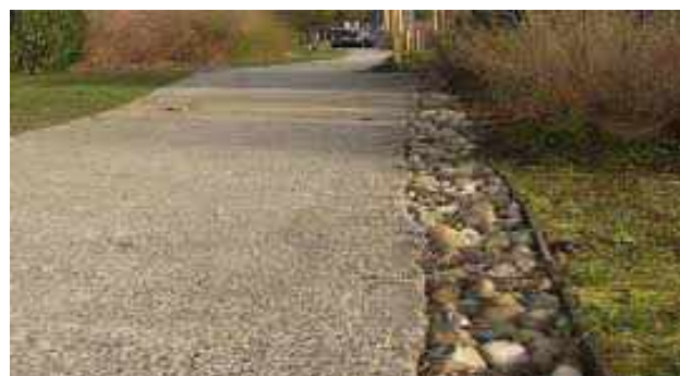
Tranchée drainante © Grand Lyon
