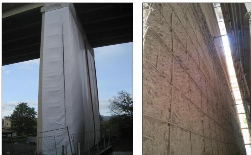
Figure n°15 : Bâche acoustique et parement hydrodémoli
