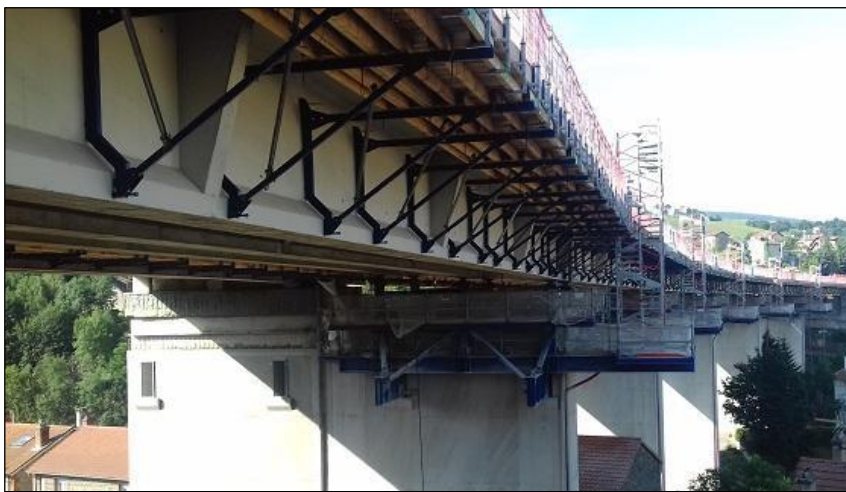
Figure n°23 : Consols métalliques en bord d'ouvrage et structure métallique porteuse en tête de pile
