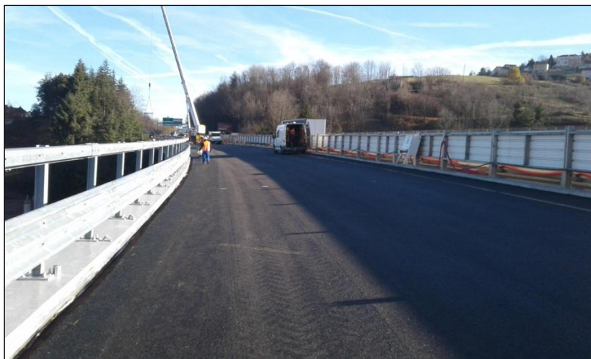
Figure n°31 : Vue des superstructures : enrobé et dispositifs de retenue
