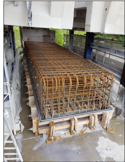
Figure n°27 : Cages d'armatures préfabriquées pour chevêtres de pile
