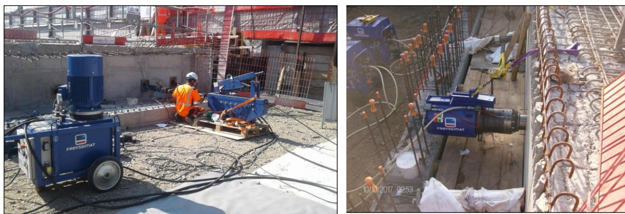
Figure n°29 : Enfilage de la précontrainte et mise en tension
