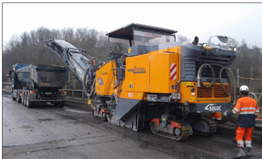
Figure n°25 : Rabotage de l'enrobé, de l'étanchéité et du renformis
