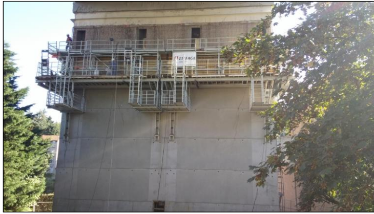
Figure n°17 : Outil auto-grimpant - Bétonnage de la 6ème levée
