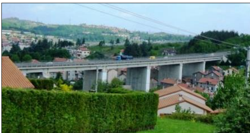
Figure n°1 : Vue générale du viaduc de la Ricamarie
