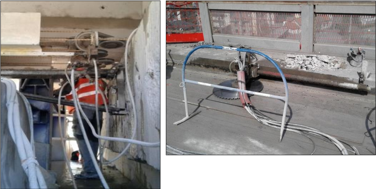
Figure n°26 : Sciage au câble et sciage au disque
