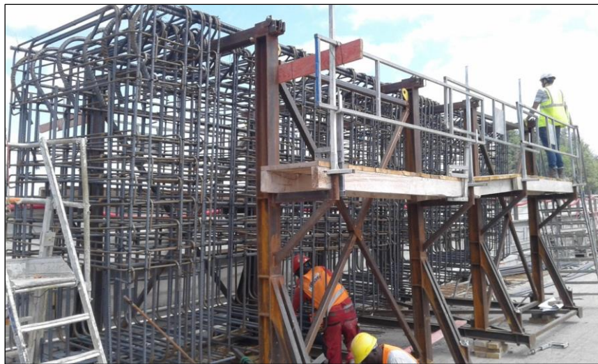
Figure n°28 : Préfabrication du ferrailage d'une entretoise de continuité
