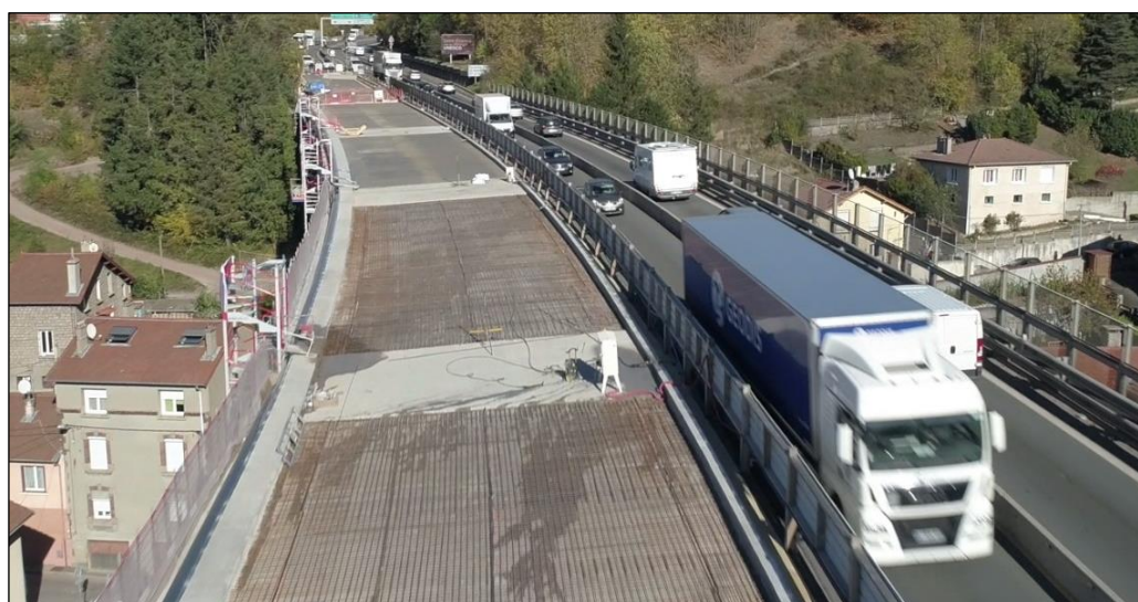
Figure n°30 : Ferrailage du hourdis additionnel
