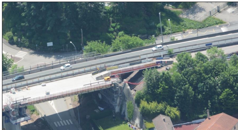
Figure n°24 : Pont d'accès provisoire au niveau de la culée C7
