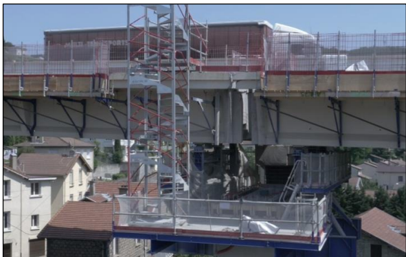
Figure n°18 : Systèmes d'appuis provisoires sur piles et sur culées
