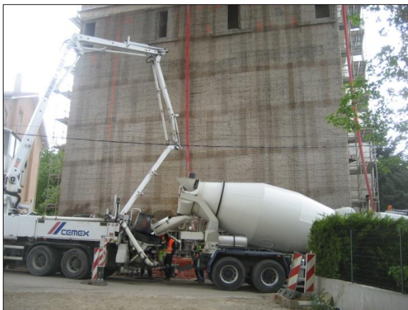
Figure n°16 : Ferrailage et bétonnage de la première levée
