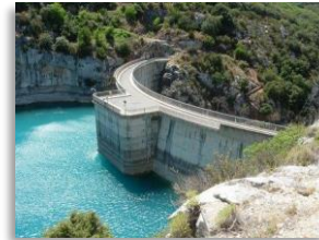
Barrage de Sainte-Croix du Verdon
