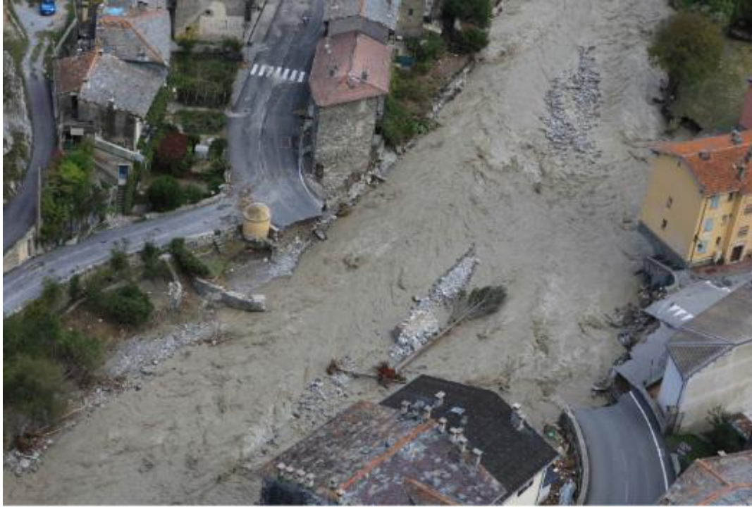
Pont du Bourg-Neuf TENDE
