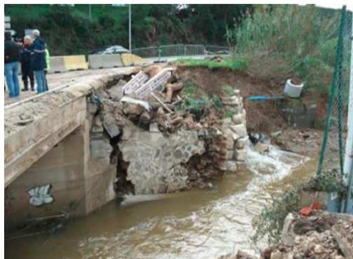
Effondrement d'une berge du pont sur le Batailler au Lavandou, inondations du Var, 2014
