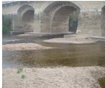
Exemple de banc d'alluvions à nu indiquant un lit mobile (photo: LR de Blois)
