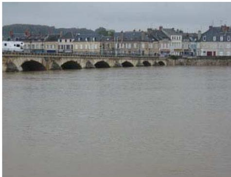
Ouvrage fluvial au débouché hydraulique sous dimensionné (photo: LR de Blois)
