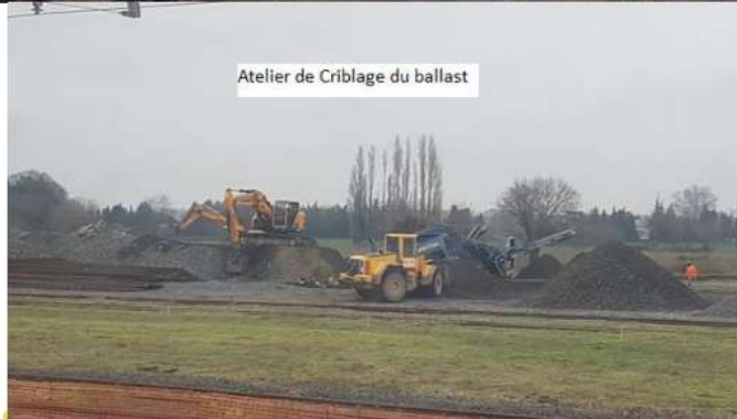
La dépose des voies HS est achevée. Evacuation des vieilles TB, des rails. Fin du terrassement V5 et pose des premiers panneaux de voie
