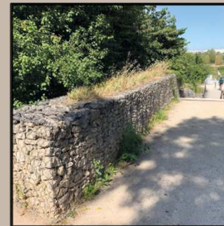
Les murs en gabion
