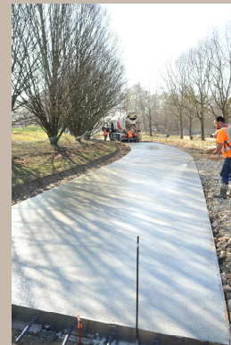
Mise en œuvre du béton
