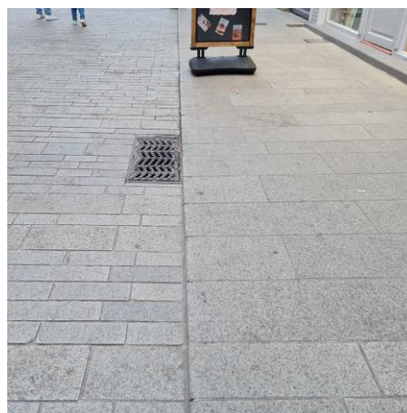
Figure 6 : Dispositif de guidage créé par un ressaut initialement prévu pour canaliser les eaux pluviales. Il permet le guidage des PAM sur un itinéraire éloigné des façades et obstacles générés par l'activité commerciale (panneaux, chevalets...). (source : Métropole de Lyon)
