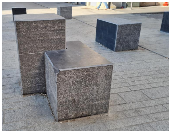
Figures 7 et 8 : La traversée perpendiculaire de l'aire piétonne par des véhicules est matérialisée par la présence de bornes en béton qui servent également dans la lutte contre les attentats, tout en permettant l'accès des pompiers. Ces plots massifs sont à la fois des repères et des obstacles. Le contraste a été créé par une face peinte en noir (source : Métropole de Lyon)
