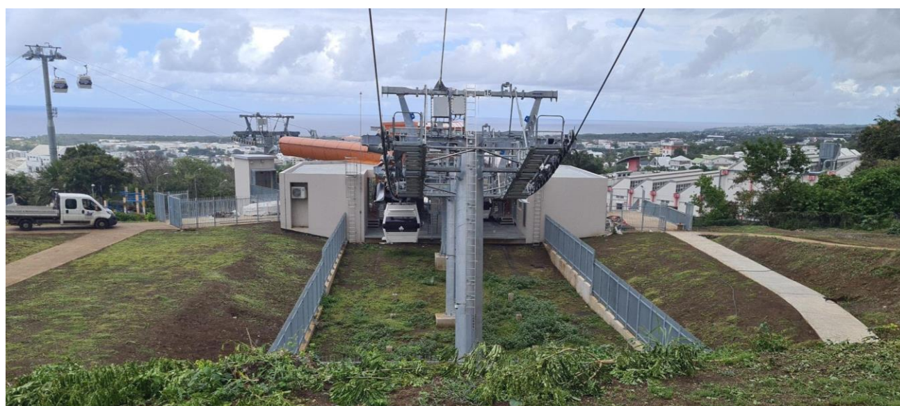
Arrivée d'une cabine à la station Moufia, à Saint-Denis (La Réunion) – Système monocâble Crédits Cerema
