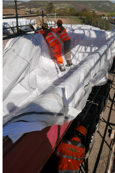
Mise en place des sacs double fermeture dans la benne du semi
