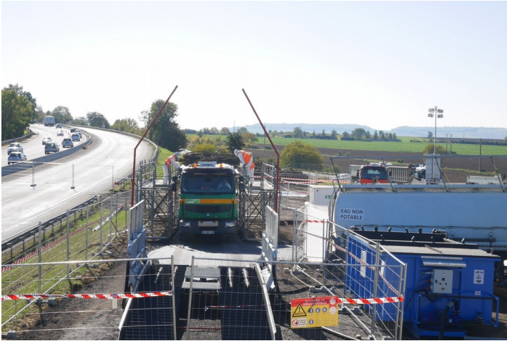
Fermeture du sac et décontamination du semi au laveur
