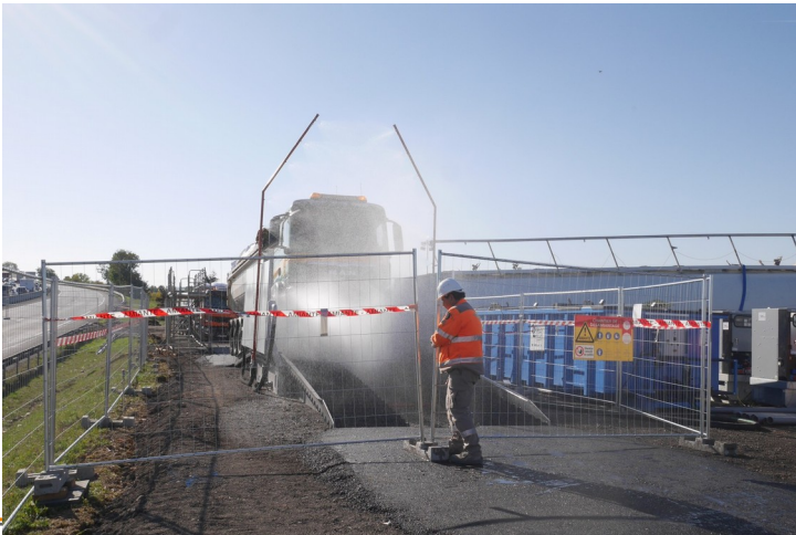
Fermeture du sac et décontamination du semi au laveur
