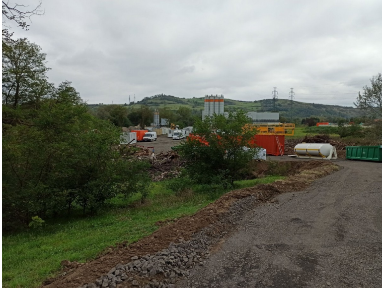
Base vie – plateforme créée pour la logistique, chemin d'accès
