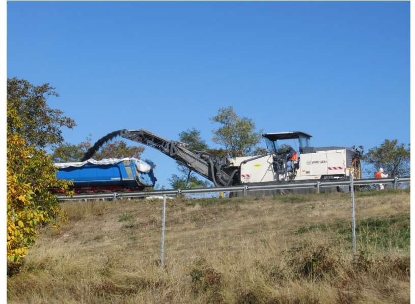
Rabotage sous amiante
