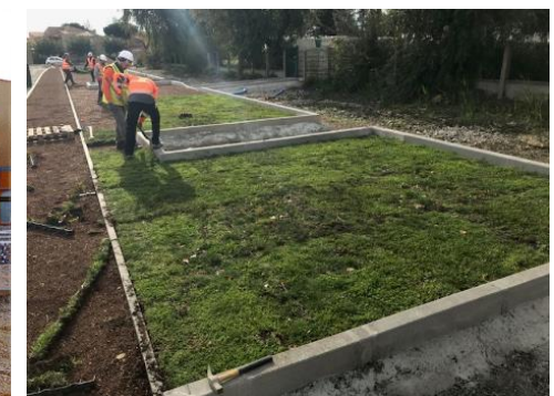
Narbonne-Plage : dalles végétalisées
