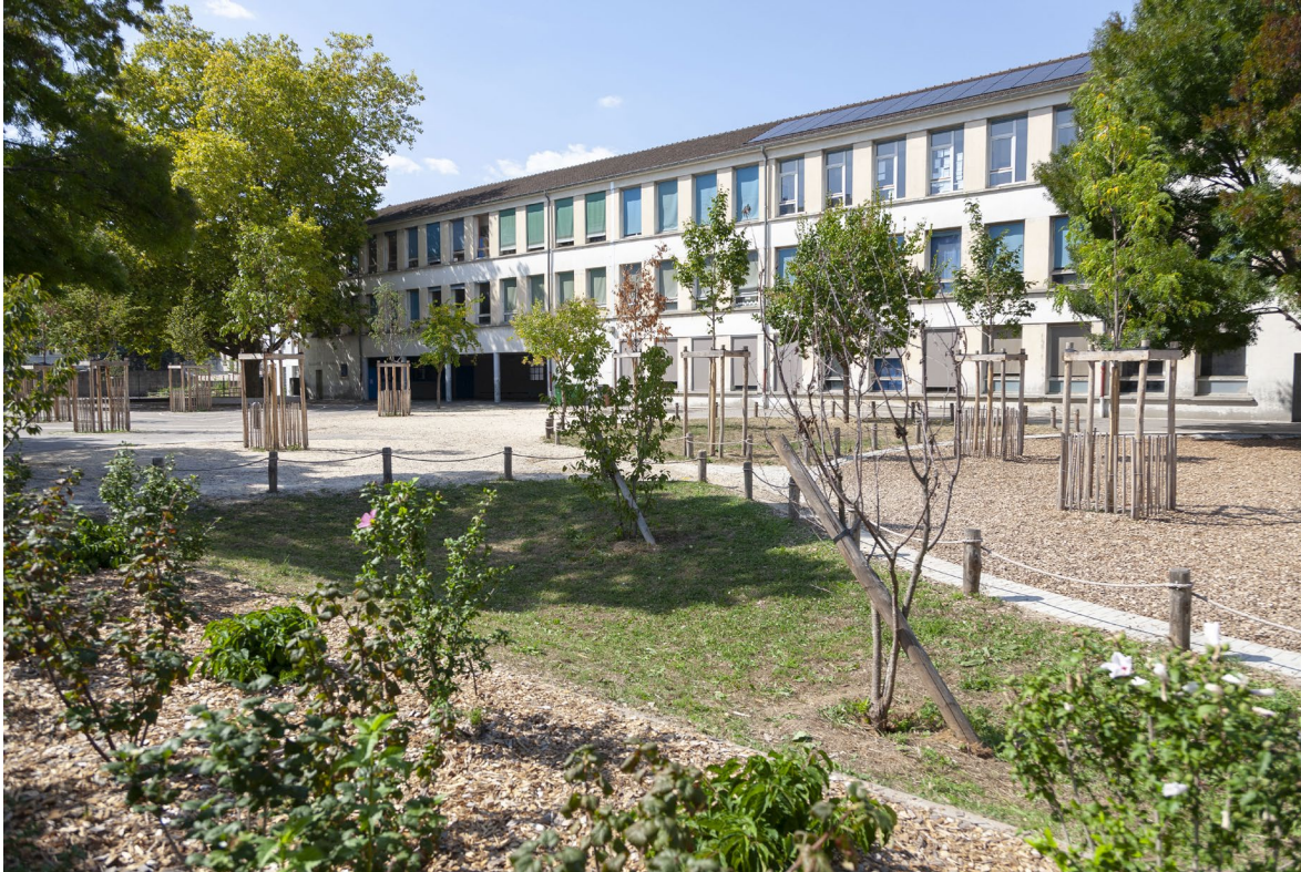
Ecole Clémenceau, Grenoble (Isère) Source : Ville de Grenoble
