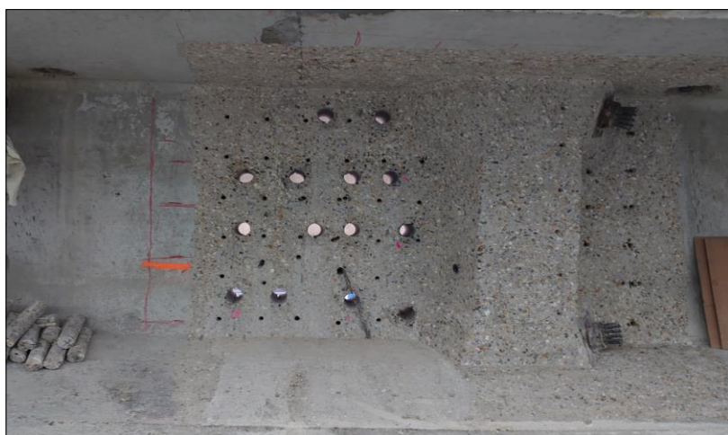
Figure n°38 : Implantation finale de la précontrainte courte
