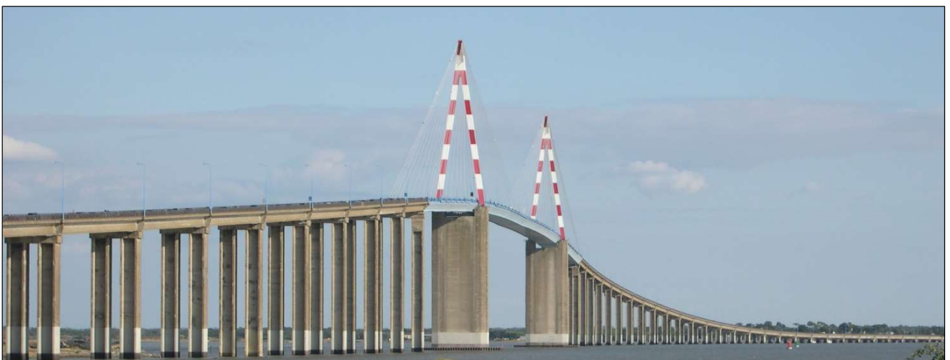
Figure n°1 : Vue d'ensemble du pont de Saint-Nazaire (photo de Ludovic Péron, sous licence GFDL [18])
