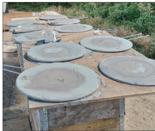
Figure n°25 : Niche de vérinage réalisée par hydro-démolition Figure n°26 : Vérins plats en préparation
