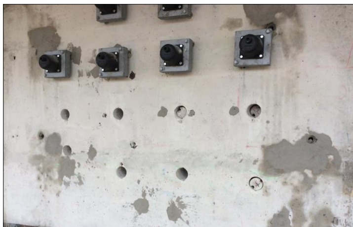
Figure n°40 : Ancrages passifs des Freyssibars
