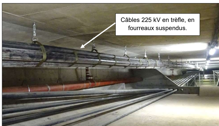
Figure n°2 : Exemple typique de suspension d'une liaison souterraine 225 kV posée en trèfle dans le tablier d'un pont
