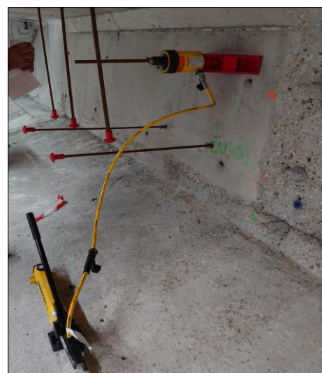
Figure n°39 : Essais de traction sur scellements
