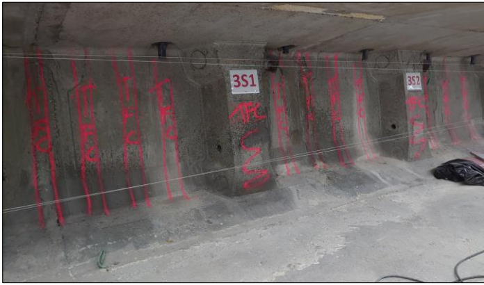
Figure n°30 : Implantation du renforcement en composites collés
