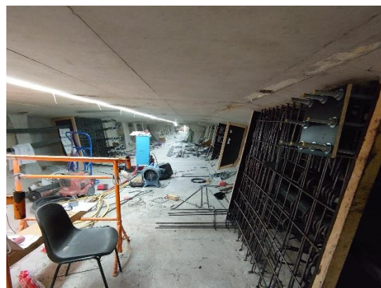
Figure n°43 : Mise en place des tiges d'ancrage pour butons métalliques
