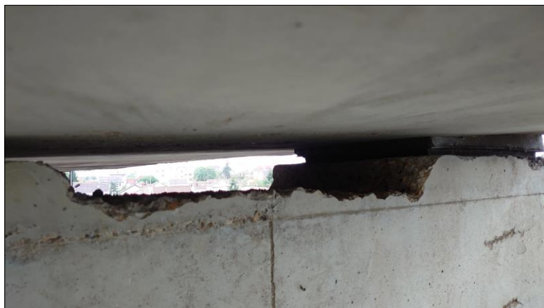
Figure n°25 : Niche de vérinage réalisée par hydro-démolition Figure n°26 : Vérins plats en préparation
