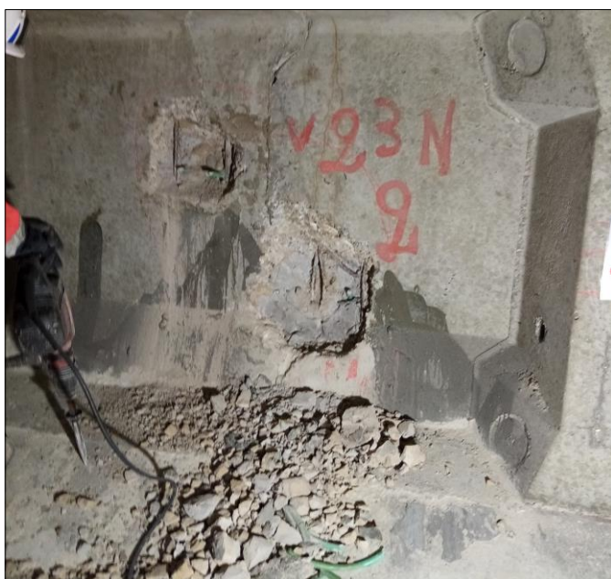
Figure n°28 : Réparations du béton
