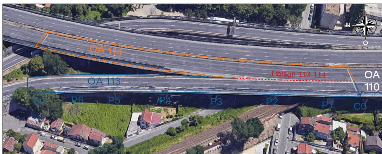
Figure n°10 : Photographie aérienne de l'OA113
