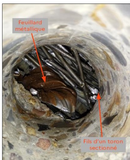
Figure n°34 : Gaine de précontrainte ouverte
