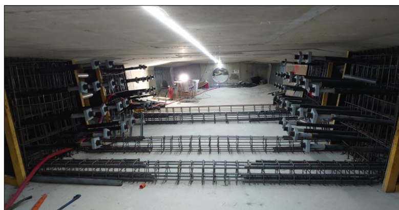
Figure n°42 : Ferrailage des massifs d'ancrage
