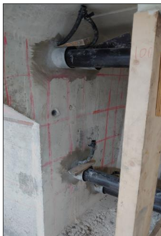
Figure n°47 : Matage des tubes déviatoriques sur piles
