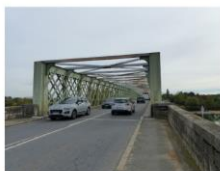
Pont sur la Saône - Situation actuelle
