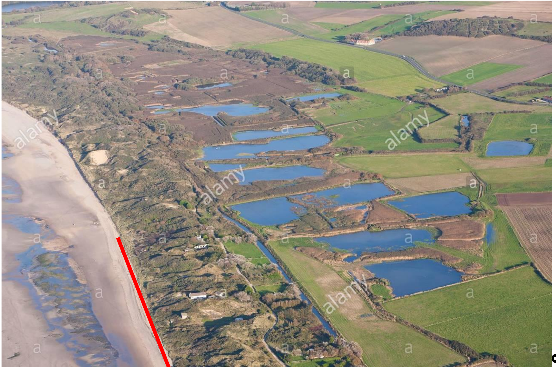
Localisation du linéaire de modules en bois, en rouge.
