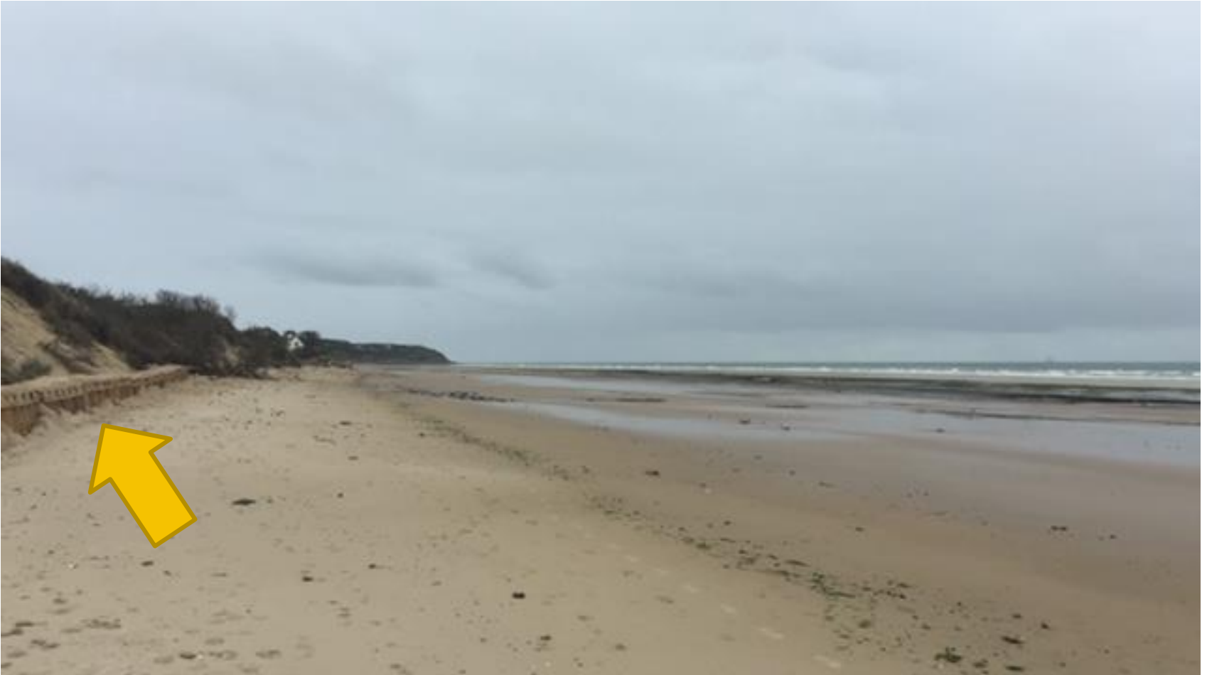
Linéaire de modules en bois, plage du Châtelet, Tardinghen, Juin 2021.
