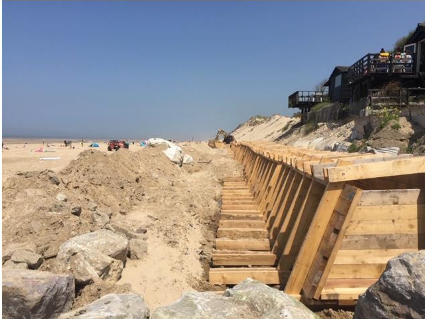
Phase d'installation du linéaire de modules en bois, dune d'amont, Wissant, Juillet 2021.
