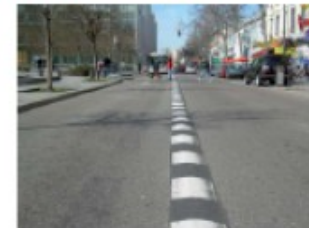
Exemple de bourrelet plus facilement perceptible. Le relief est plus facile à percevoir avec un marquage alternatif. Ceci sera repris dans une modification à venir de l'NSR, qui imposera que « si la couleur et le contraste du séparateur par rapport à la chaussée ne permettent pas d'assurer une bonne perception, le séparateur doit être peint à l'aide d'un marquage T2 (50 cm blanc, 50 cm noir), de largeur égale à celle du séparateur ».
