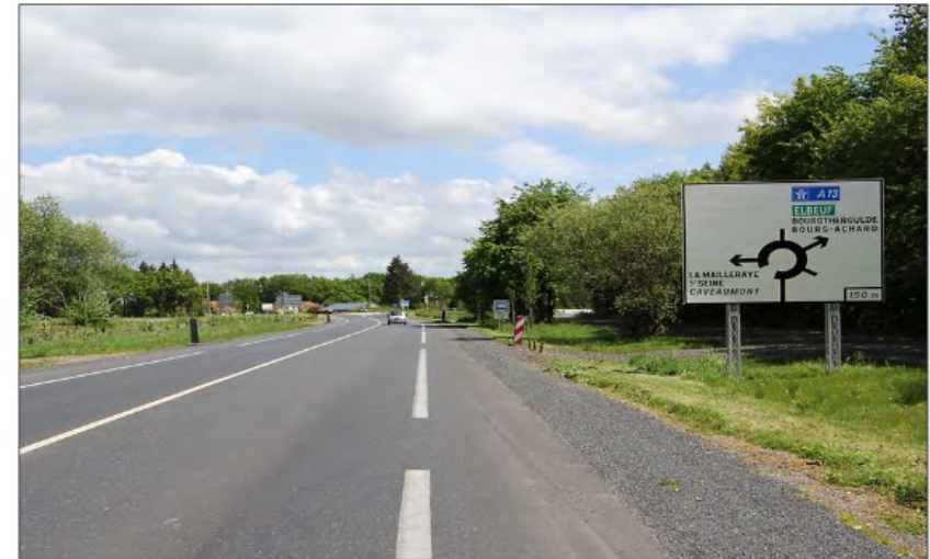
Illustration 15 : Support de signalisation à sécurité passive (Source Département de Seine-Maritime, 2013)
