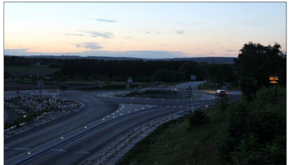
Illustration 14 : Giratoire RD490/RD131 - Balisage lumineux par LED : balisage actif en périphérie de l'anneau central et fixe sur les îlots séparateurs du giratoire (Source : Cerema Normandie-Centre, 2014)
