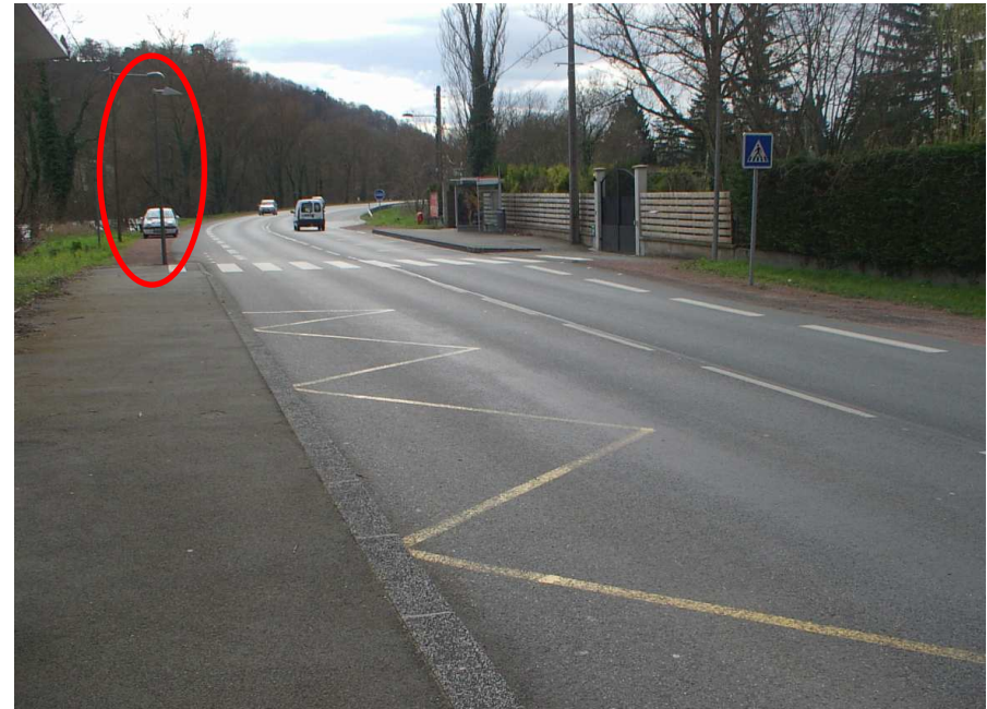
Éclairage dédié au passage piéton
