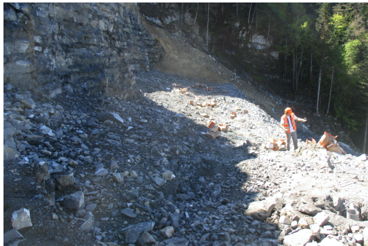
Chargement d'un tir dans une carrière de Haute-Savoie
