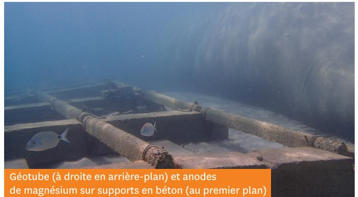
Géotube (à droite en arrière-plan) et anodes de magnésium sur supports en béton (au premier plan)
