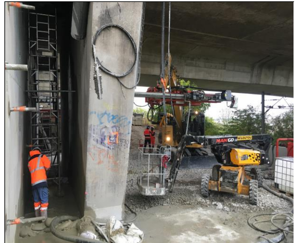
Figure 33 : Clouage du mur de front à travers le voile de la culée du viaduc de Gennevilliers
