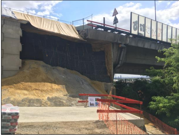
Figure 18 : Installation du ferrailage au droit de la zone
