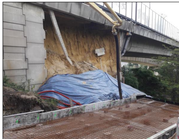
Figure 13 : Ferrailage de la dalle d'accès à la zone effondrée
