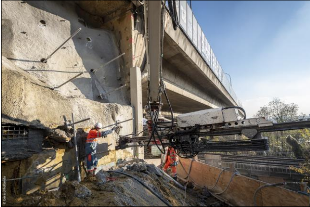
Figure 36 : Forage au droit de la zone effondrée
