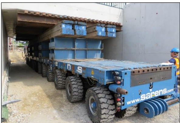
Photo 7 : Palée supportant un petit portique au niveau de sa traverse
