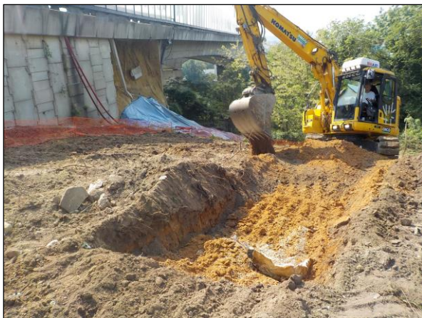
Figure 12 : Travaux de la piste d'accès à la zone effondrée
