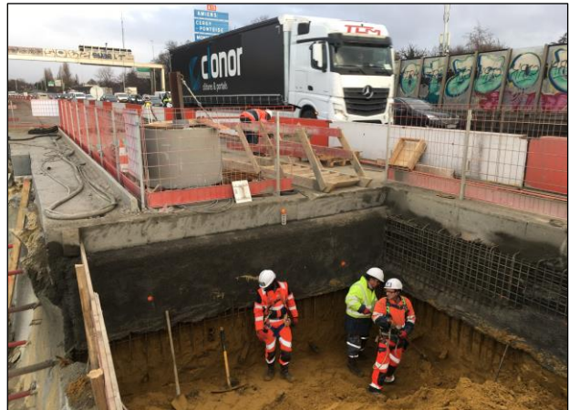
Figure 42 : Blindage de la fouille
