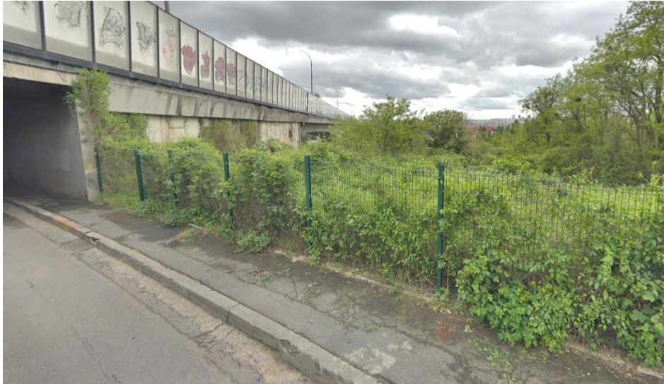
Figure 2 : Photo de la zone avant l'effondrement
