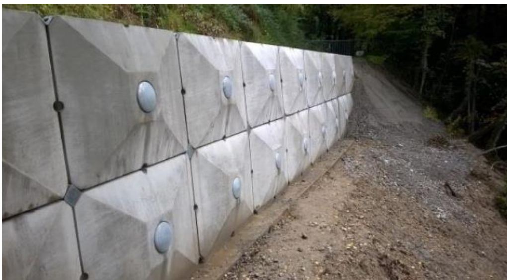
Figure 22 : Exemple d'utilisation de paroi AD/OC
