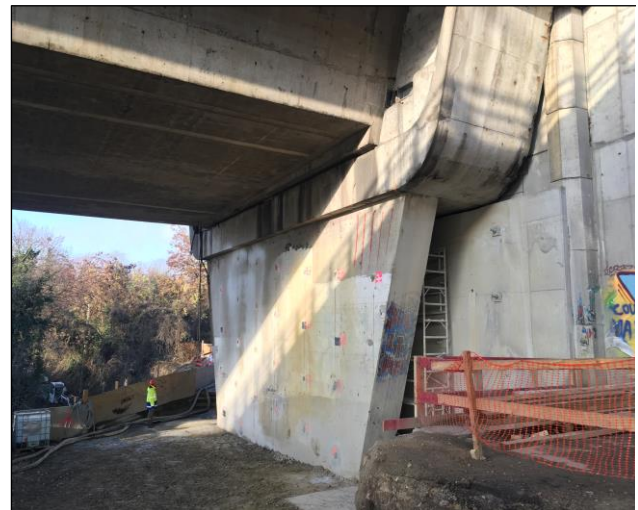
Figure 35 : Culée de l'ouvrage à la fin du chantier
