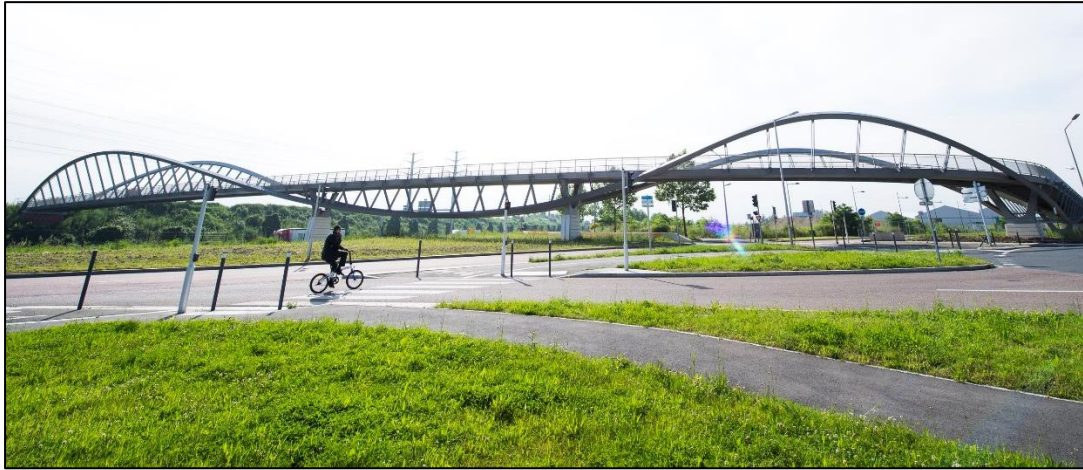
Photo 29 : La passerelle Tegeval sur la RN406, à Valentigney (94)
