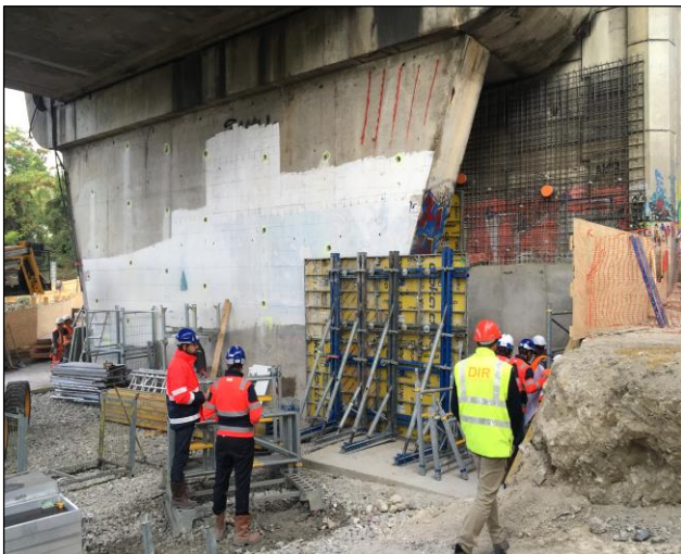
Figure 34 : Mise en œuvre du coffrage du voile en béton devant le mur de front de la culée
