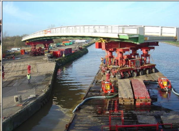
Photo 22 : Mise en place d'un tablier en acier avec deux chariots automoteurs dont un placé sur une barge
