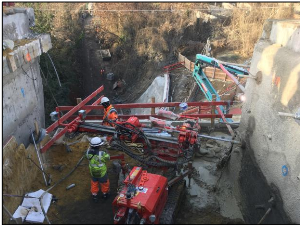
Figure 43 : Forage réalisé depuis la niche
