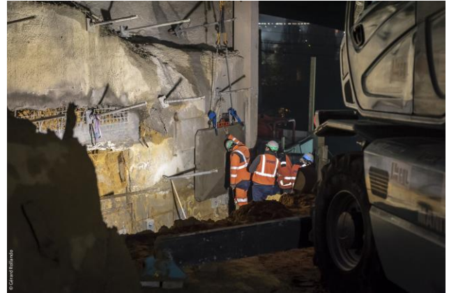
Figure 37 : Mise en œuvre d'une écaille AD/OC en déblai
