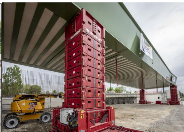
Photo 13 : Tour de vérinage à caissettes utilisée pour lever un tablier avant sa prise en charge par des chariots automoteurs
