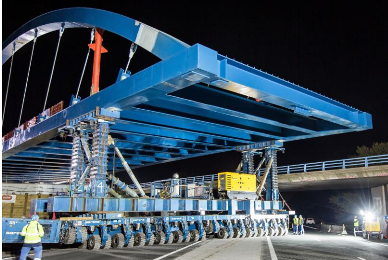
Photo 11 : Palée avec tours de vérinage supportant un tablier en acier de type bow-string
