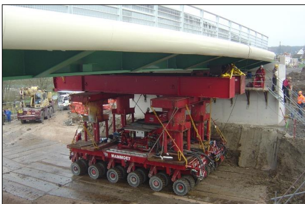
Photo 9 : Palée avec tubes et chevêtres supportant un tablier de pont en acier
