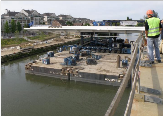
Photo 21 : Mise en place d'un tablier en acier avec un seul chariot automoteur placé sur une barge
