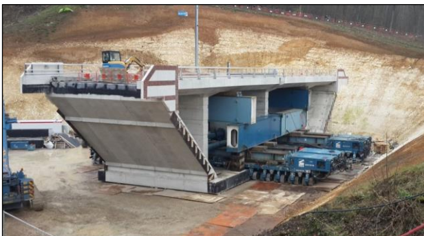
Photo 17 : Mise en place d'un double cadre avec poutres transferts
