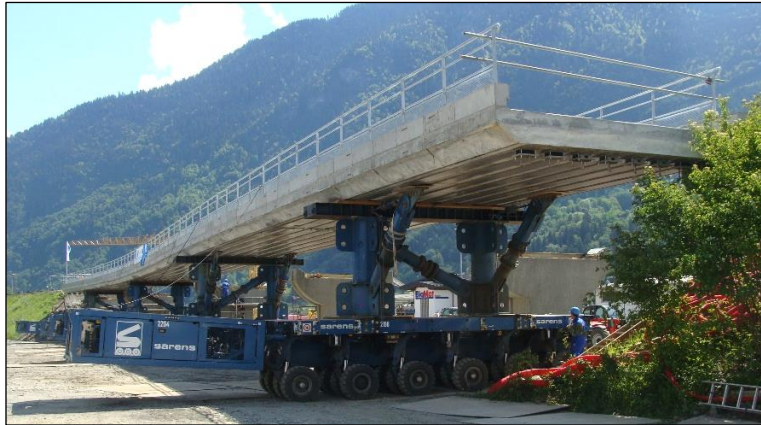
Photo 3 : Préparation du ripage d'un tablier multi-travées à poutrelles enrobées
