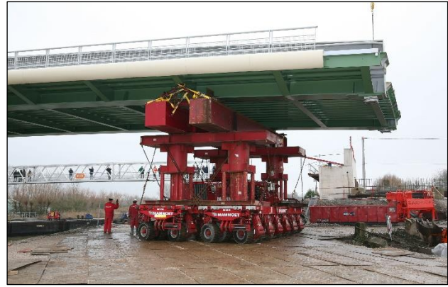
Photo 2 : Mise en place d'un tablier de pont en acier
