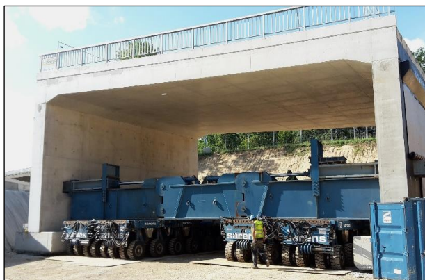
Photo 8 : Palée avec poutres transversales supportant un portique par ses deux piédroits
