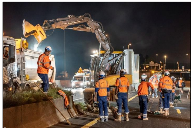
Photo 27 : TPC en cours de démolition avant une opération de ripage
