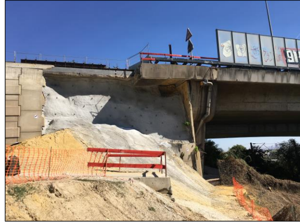
Figure 19 : Vue d'ensemble après stabilisation de la zone
