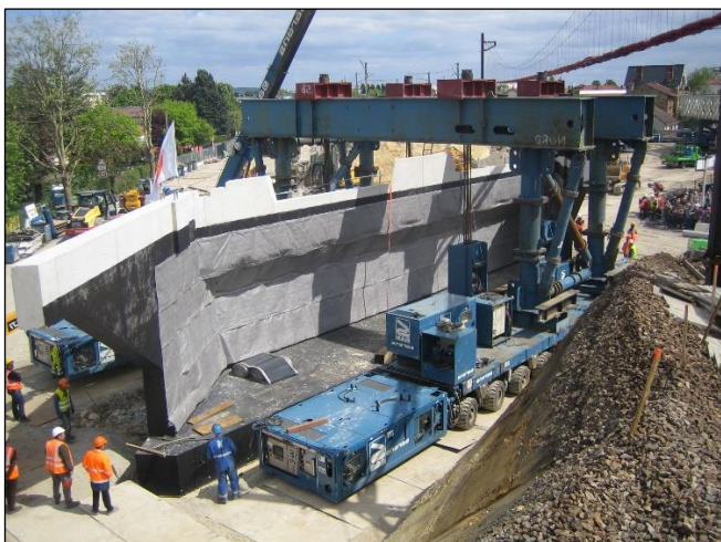
Photo 19 : Mise en place d'une culée préfabriquée à mur de front
