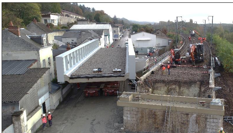
Photo 28 : Transport du nouveau tablier du pont-rail de Montrichard à travers le centre-ville
