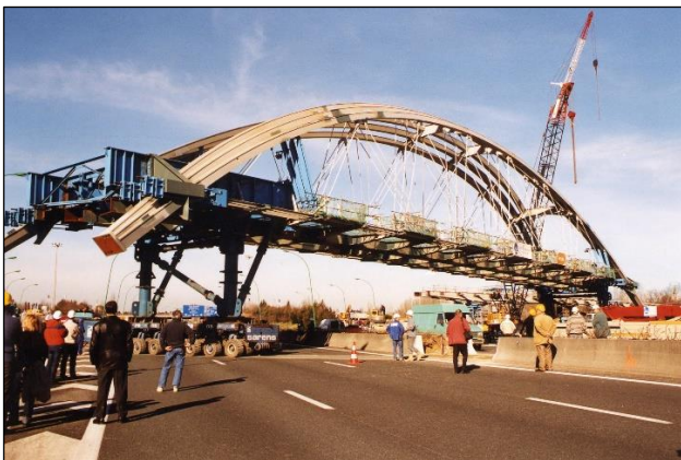
Photo 26 : Chariot automoteur franchissant un TPC partiellement démolli
