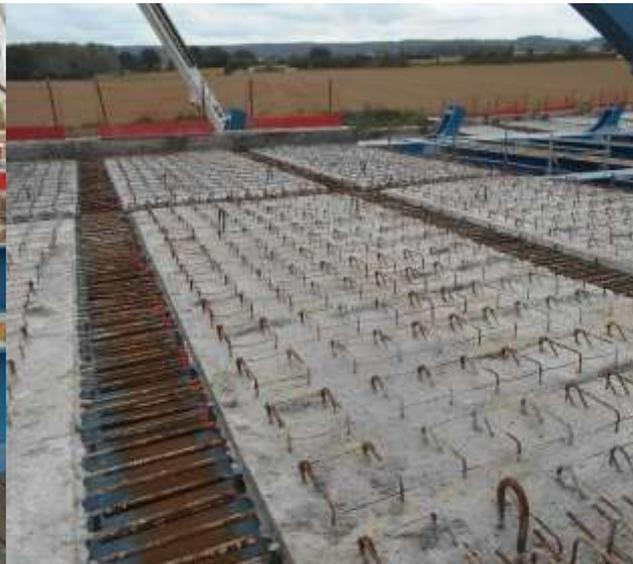
Figure 18: Clivages longitudinal et transversal des prédalles
