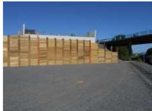
Figure 14 : Soutènements provisoires
