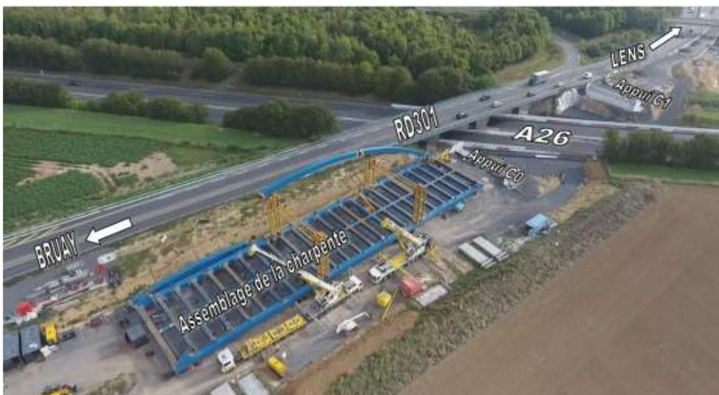
Figure 10 : Assemblage de la charpente sur l'aire de lancement
