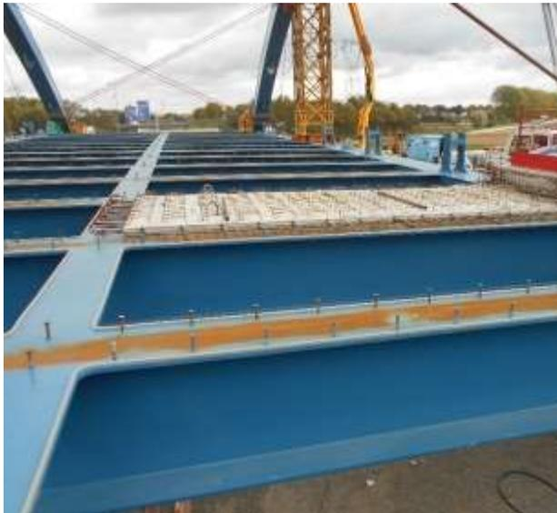
Figure 17 : Condition d'appuis des prédalles
