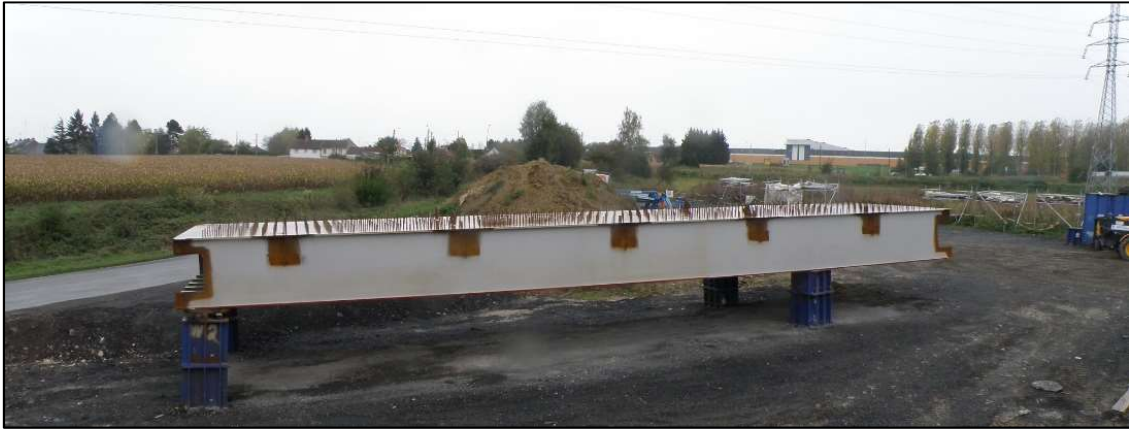
Figure 18 : Tronçon de caisson de charpente (Cerema NP)
