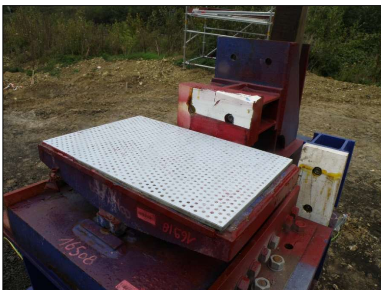
Figure 17 : Plaque téflon sur appui provisoire (Cerema NP)
