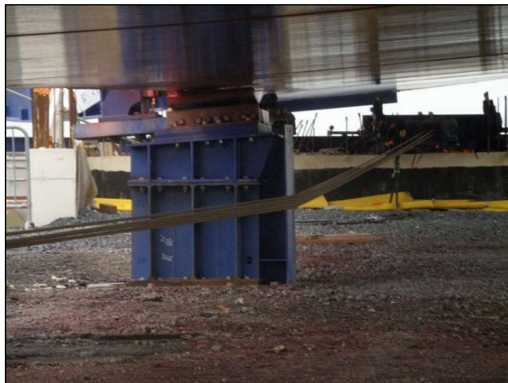
Figure 23 : Câble de lançage (Cerema NP)
