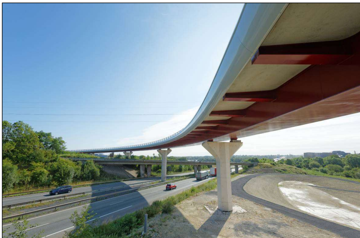
Figure 1 : Vue générale de l'ouvrage
