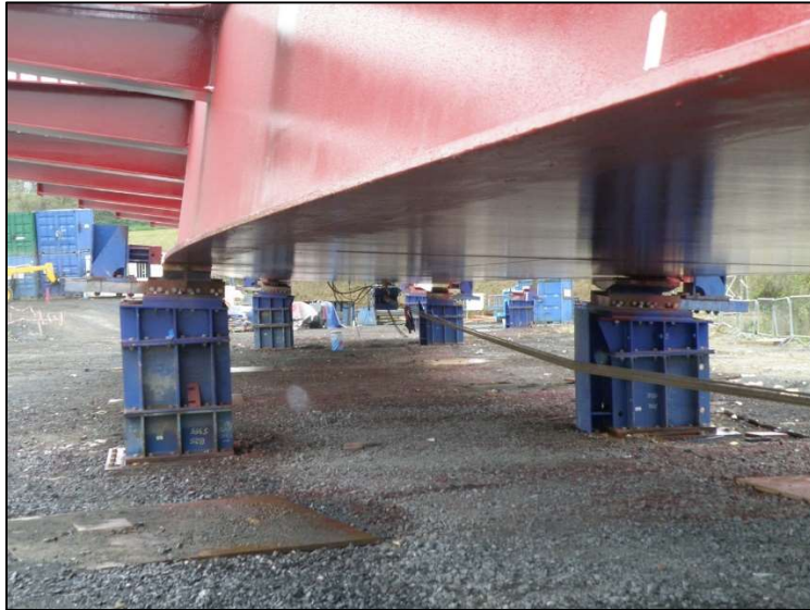
Figure 22 : Câble de lançage (Cerema NP)
