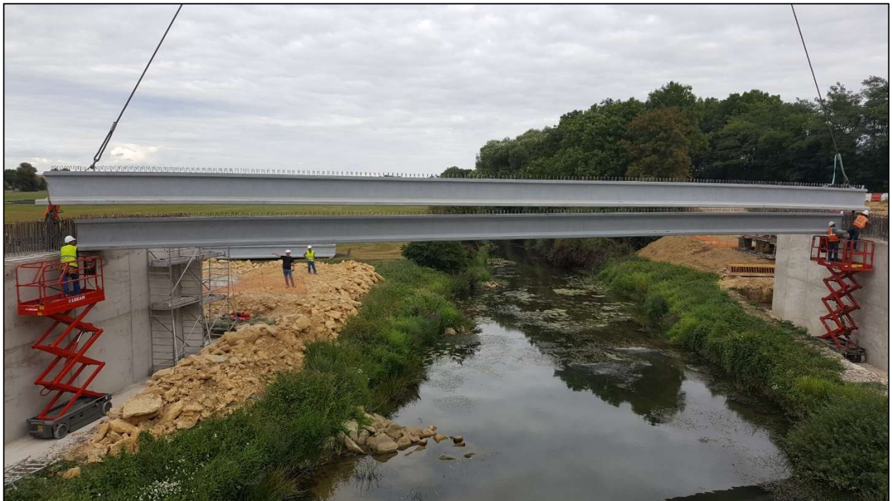
Figure 16 : Mise en place des poutres à la grue mobile
