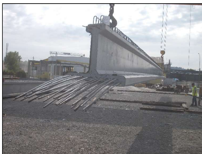
Figure 15 : Stockage des poutres en BFUP
