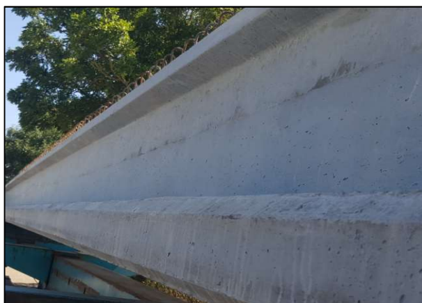
Figures 20 et 21 : Défauts d'aspect sur les poutres
