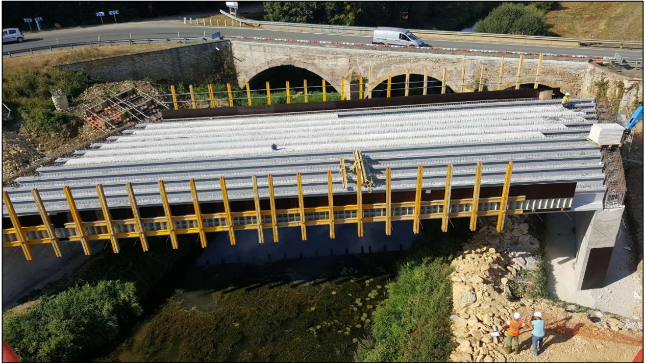
Figure 17 : Pose des coffrages perdus sur les poutres en place
