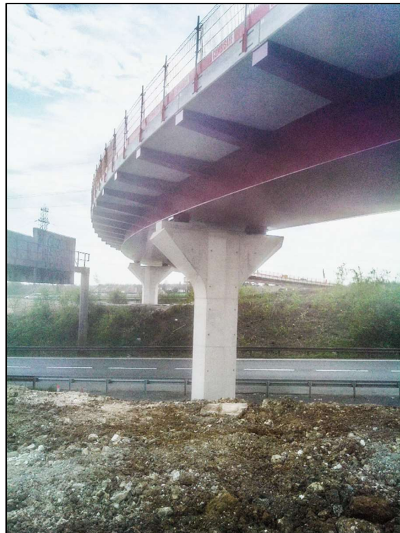
Figure 8 : Pile du viaduc (2) (Cerema NP)
