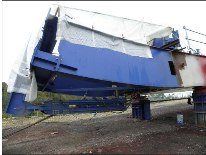
Figure 20 : Vérin installé sur l'arrière-bec (Cerema NP)
