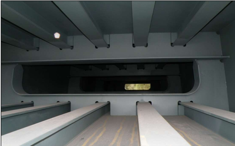
Figure 12 : Vue d'un diaphragme (Cerema NP)
