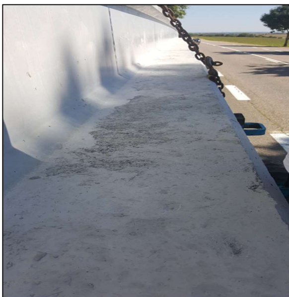
Figures 20 et 21 : Défauts d'aspect sur les poutres
