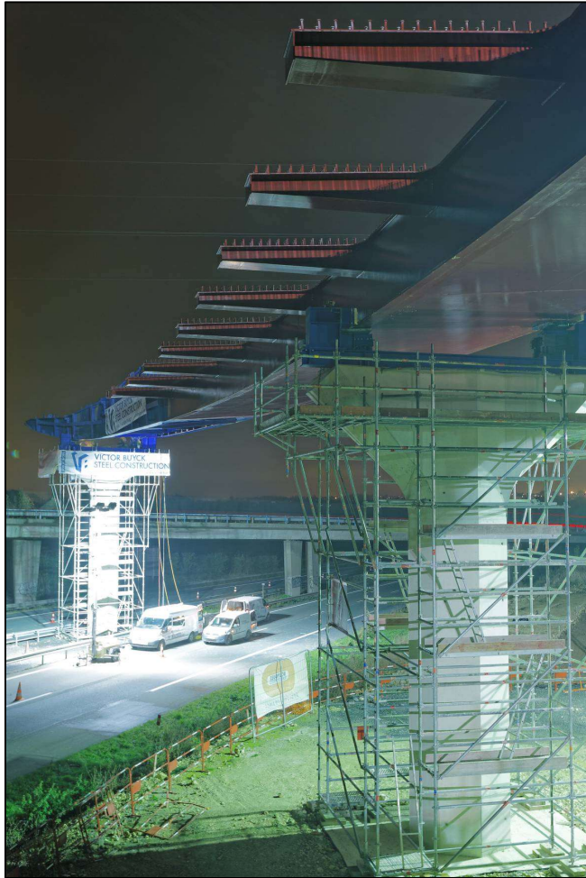
Figure 26 : Lançage de la charpente (2)
