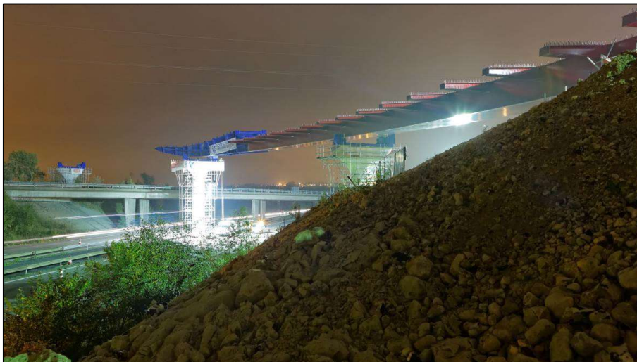
Figure 25 : Lançage de la charpente (1)
