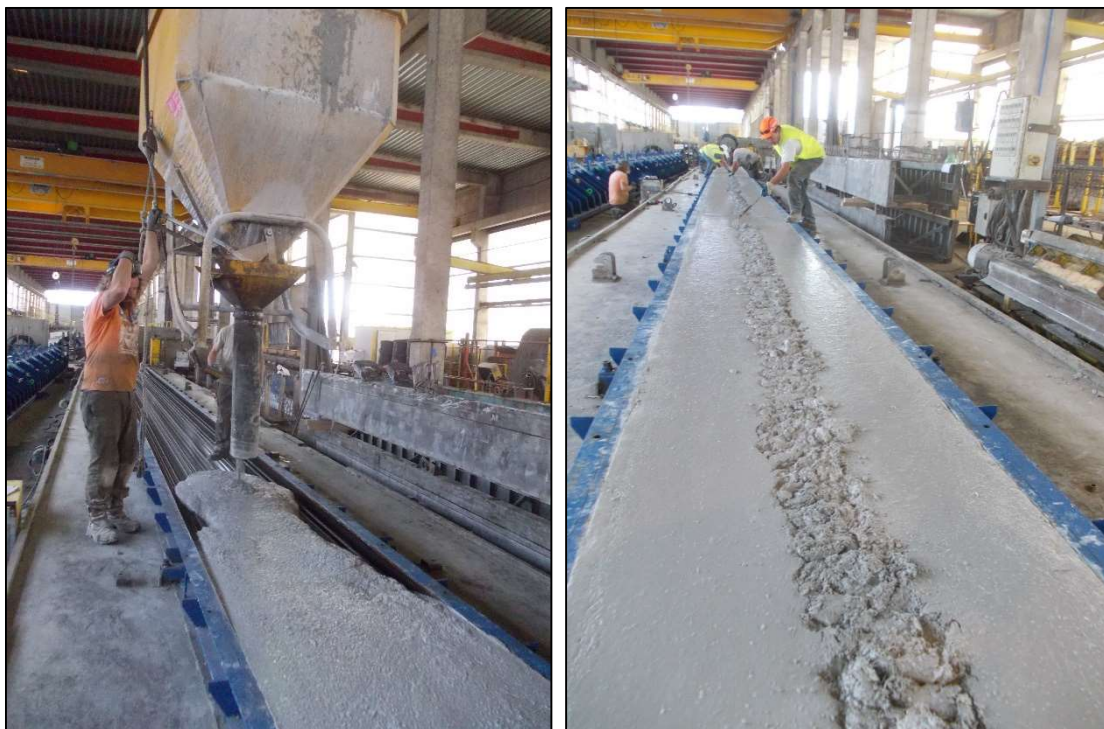
Figures 12 et 13 : 1 ère phase de bétonnage des poutres ITE
