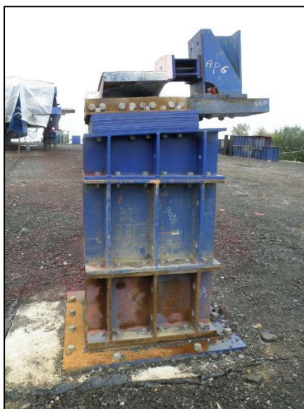
Figure 16 : Appui provisoire (Cerema NP)
