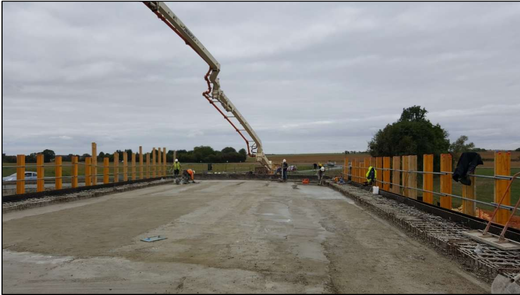
Figure 19 : Bétonnage du hourdis
