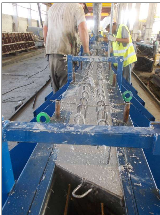
Figure 14 : 2ème phase de bétonnage des poutres ITE
