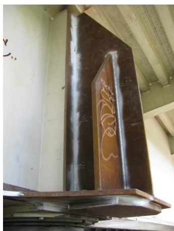
Figures 6 et 7. A gauche renforcement des poutres – A droite, renforcement des têtes de piles
