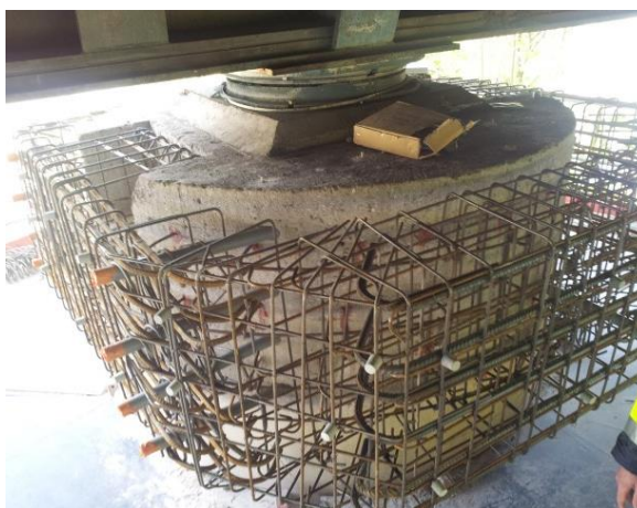
Figures 6 et 7. A gauche renforcement des poutres – A droite, renforcement des têtes de piles
