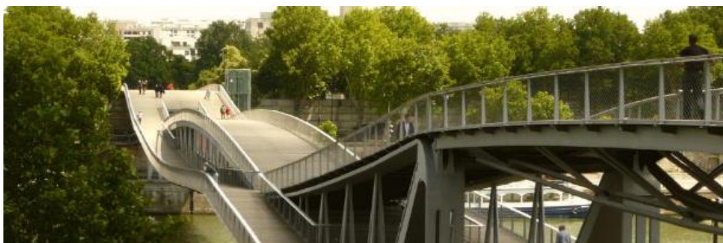
Figure 1 : La passerelle ludique Simone de Beauvoir entre BNF et parc sur la Seine.
