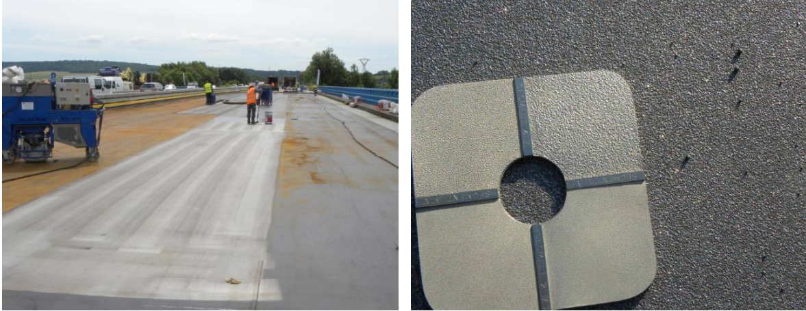
Figures 13 et 14 : Vue du décapage du tablier et du contrôle de la rugosité
