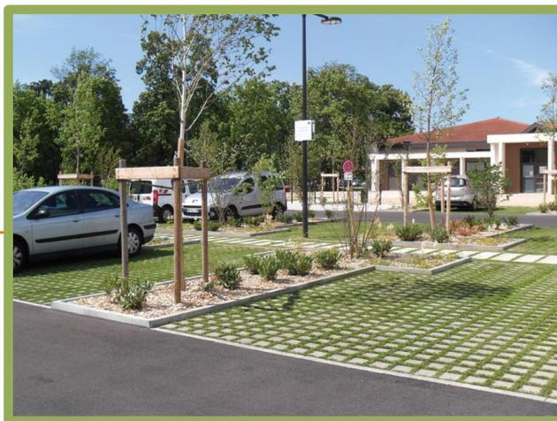
Des pavés béton avec joints engazonnés
